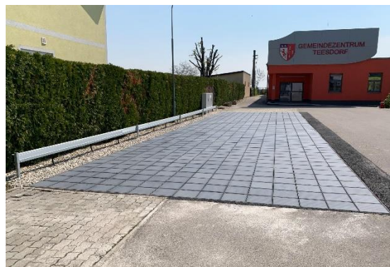
Abbildung 48: Solarer Parkplatz Teesdorf (Foto: Alexander Erber)
