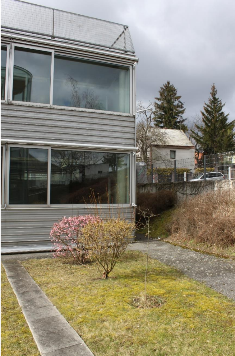
Abbildung 12: Aufnahme Fassade Klassentrakt, Februar 2021
