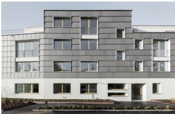
Abbildung 42: Projekt der Umwelt Arena Schweiz (Zusammenarbeit mit René Schmid Architekten AG. Photograph: Beat Bühler)
