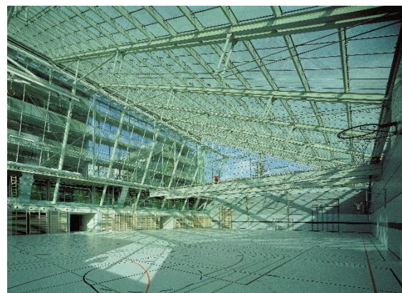
Abbildung 2: Dreifachturnhalle, Foto: Mischa Erben
