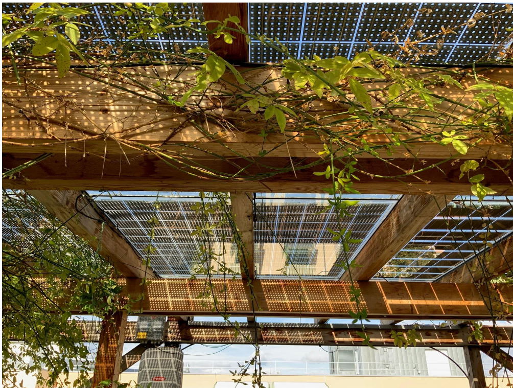
Abbildung 50: PV-Glasdach in einem Dachgarten auf der BOKU, die unterschiedliche Intensität der Perforation veranschaulicht die Abschwächung der Kontraste im Schattenwurf bei mehr Perforation
