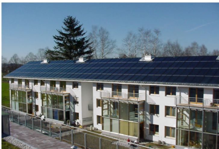
Abbildung 3.20: Wohnsiedlung Gneis-Moos, Südansicht des Gebäudeabschnittes mit 400 m 2 Kollektorfläche (Bildquelle: GSWB Salzburg)
