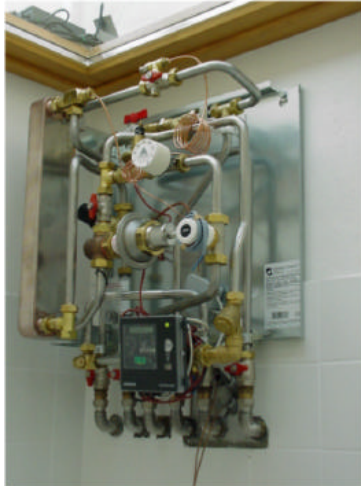
Abbildung 3.19: Vorinstallierte Wohnungsstation mit externem Wärmetauscher zur Brauchwassererwärmung und sämtlichen Komponenten für den Heizbetrieb inkl. Wärmemengenzähler (Produkt: Gemina-Termix, Bildquelle: GSWB, Salzburg)
