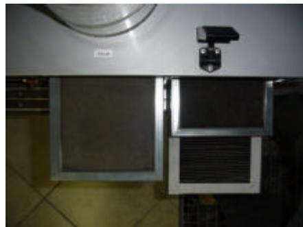
Abbildung 11: Lüftungsgerät mit einer Kombination aus Matten- und Kassettenfilter im Zuluftstrang (rechts) sowie einem einfachen Mattenfilter in Abluftbereich (links)
