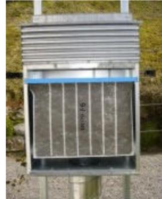
Abbildung 7: Frischluftansaugung – Ansaugfilterkasten mit Feinstaubfilter F6 in Taschenfilterausführung
