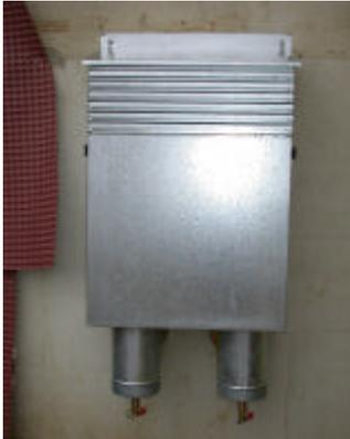
Abbildung 5: Frischluftansaugung – Ansaugfilterkasten mit Feinstaubfilter F6 in Taschenfilterausführung
