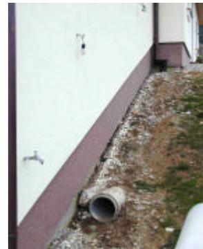
Abbildung 8 a - c: Frischluftansaugungen werden sowohl bei der Installation (Investition) als auch bei der Wartung oft stiefmütterlich behandelt
