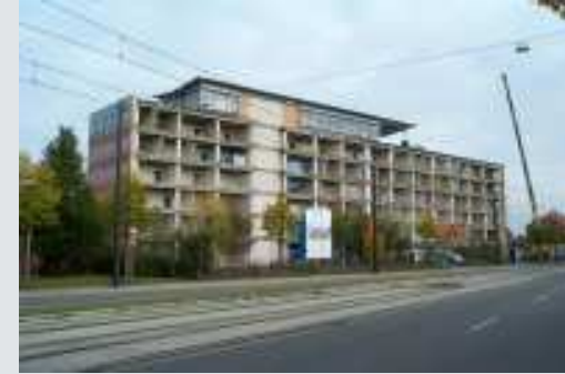
Südfassade vor Montagebeginn
