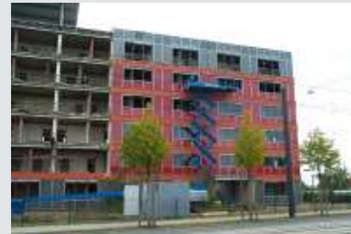
Gerüstlose Montage Arbeitsbühnen und K
