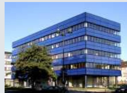
Allianz Bürogebäude nach der Sanierung
