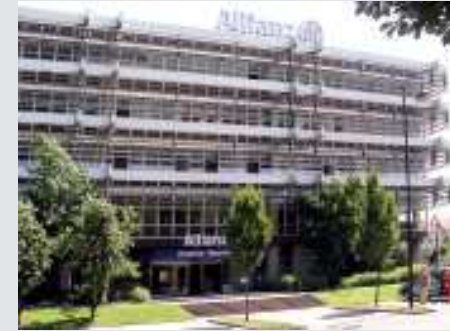
Allianz Bürogebäude vor Sanierung
