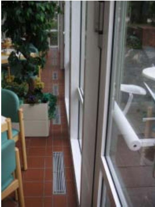
Abb. B1: Unterflurkonvektor und Heizkörper
