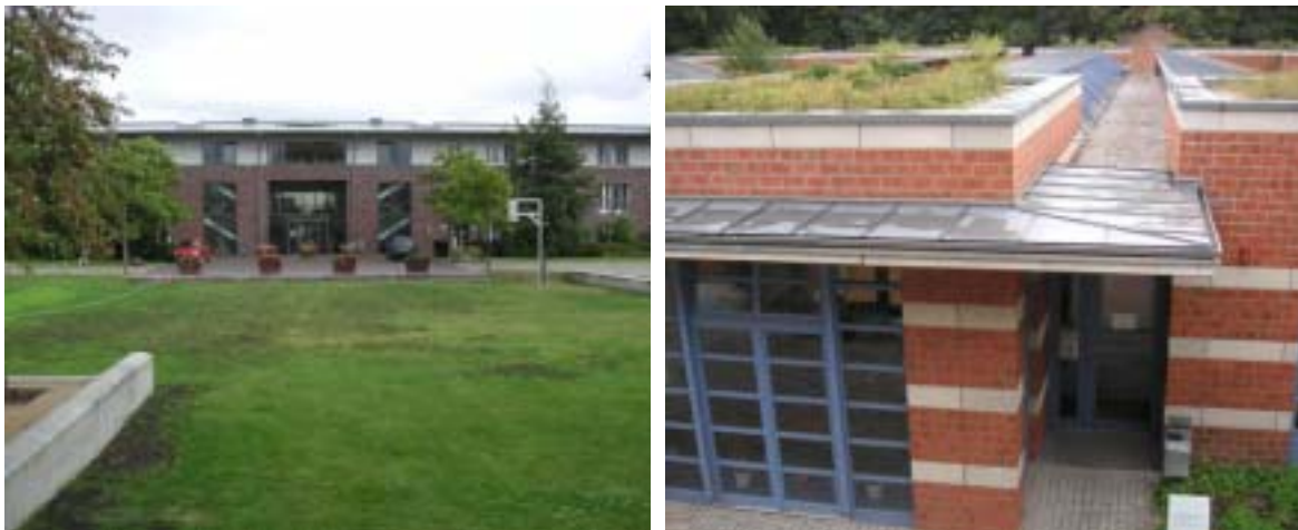
Abb.W3: Regenwasserzisterne unter der Grünfläche zur Bewässerung der Gründächer im St. Joseph-Krankenhaus
