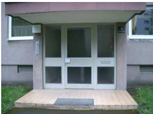
Abb. 7 Eingang Bestand Weinheberstr. 5
