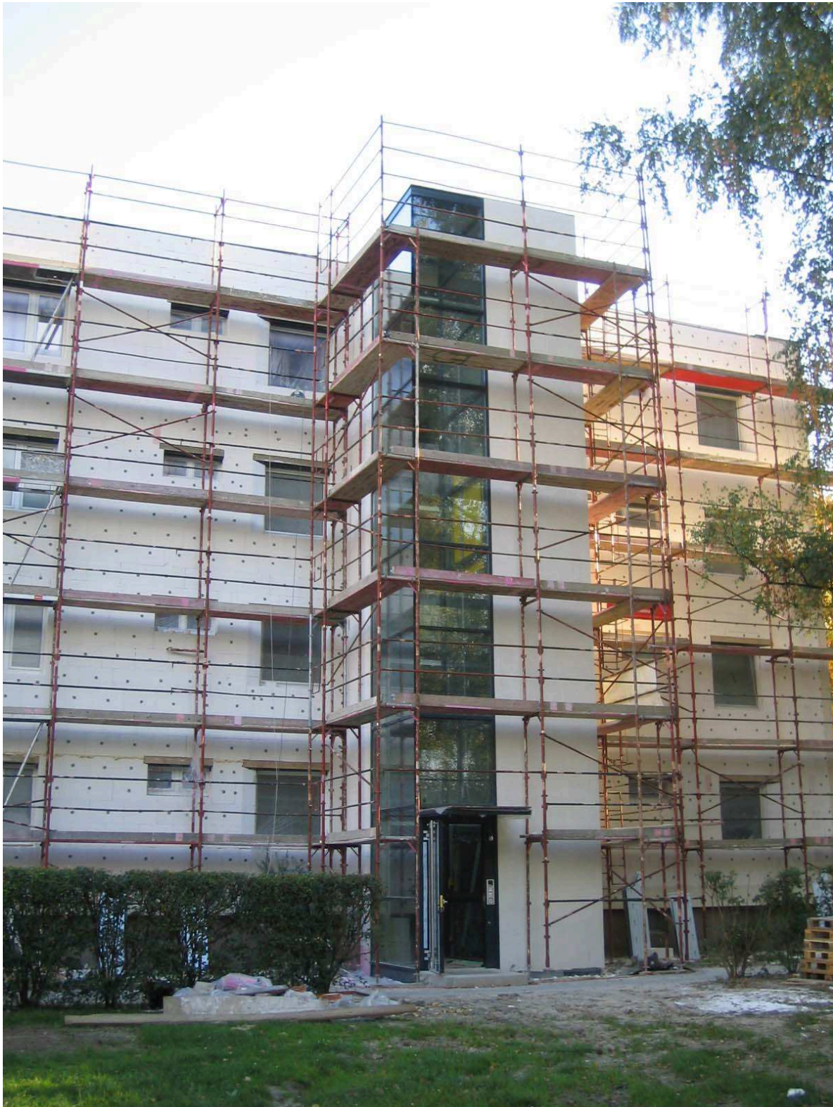
Abb. 46 Ansicht während der Sanierung
