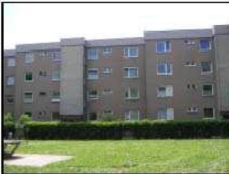
Abb. 19 Foto Ansicht Nord Bestand
