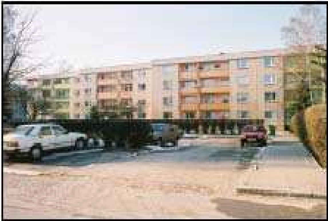
Abb. 22 Foto Ansicht Süd Bestand
