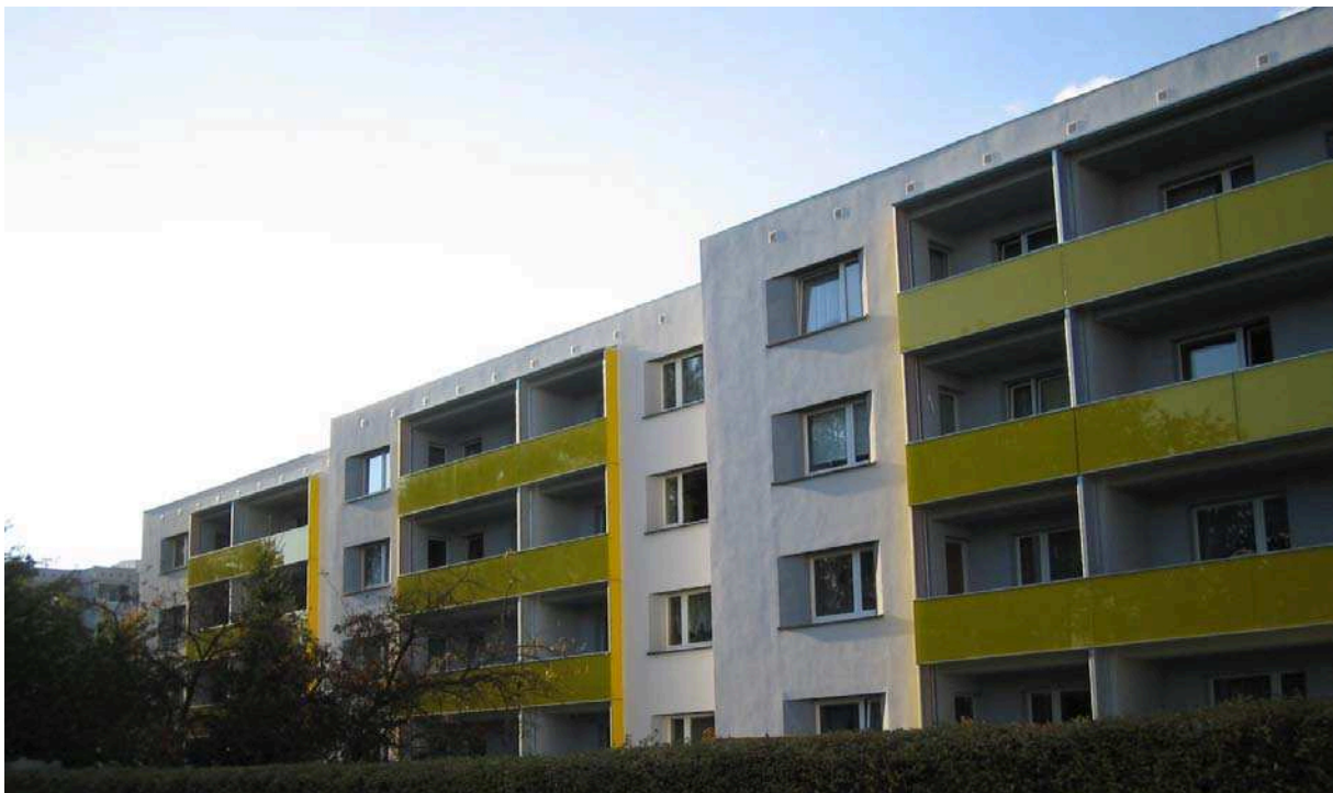
Abb. 45 Ansicht nach der Sanierung
