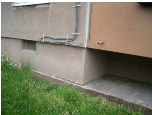
Abb. 6 Sockel Bestand im Loggiabereich
