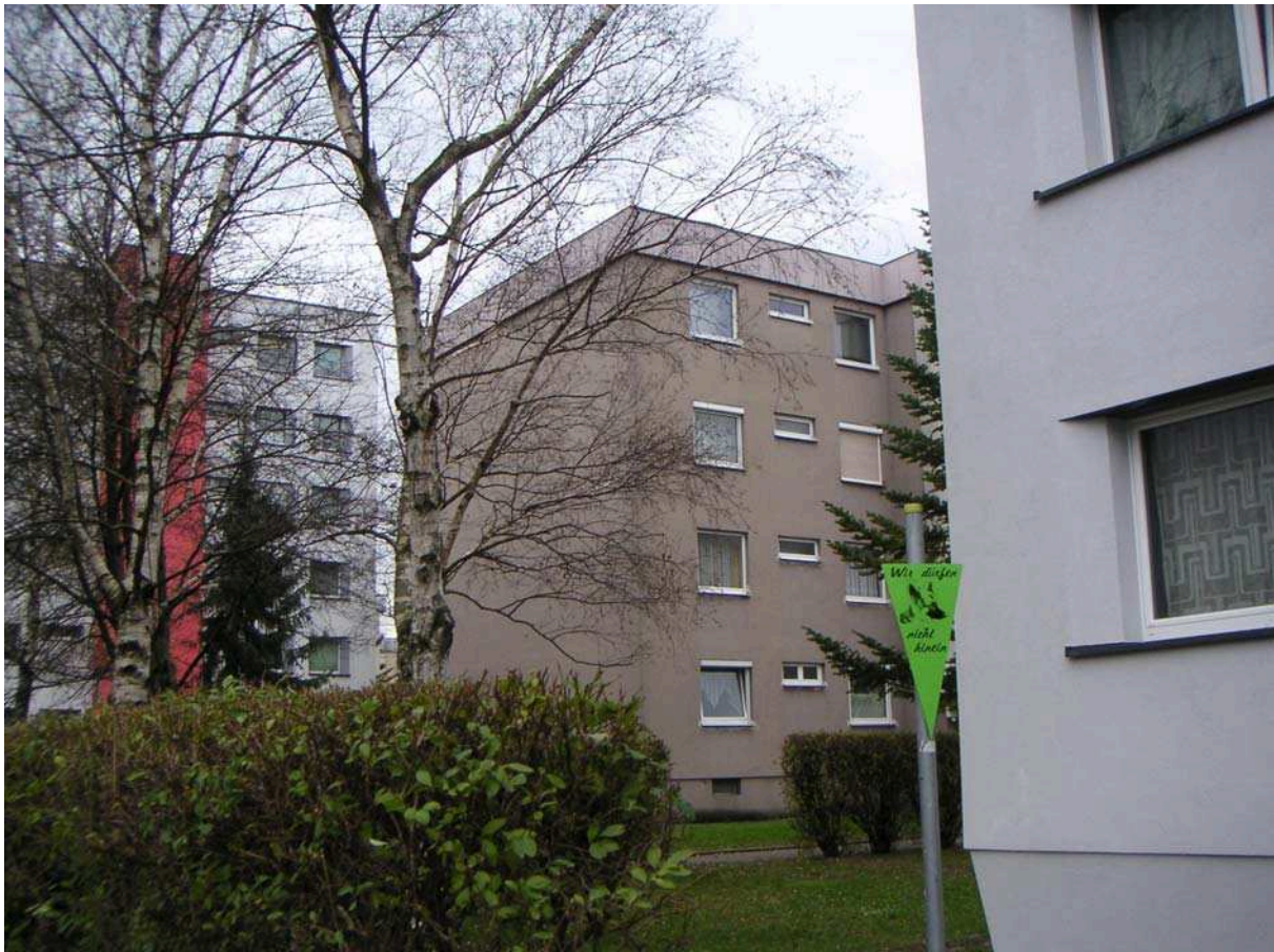
Abb. 16 Weinheberstr. 3,5,7,9 zwischen den bereits Sanierten Objekten am Spallerhof
