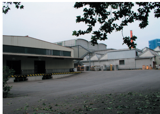
Abb. 16: Ladezone rückwärtige Halle
