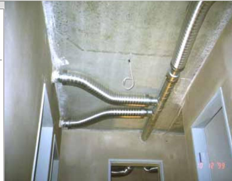
1 Schema Abluft / Zuluft, Verteilung über abgehängter Decke in Flur und Bad/ WC
