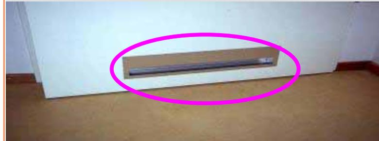
2 Vergrößerung des Luftspaltes bei höherem Luftwechsel zwischen den Räumen
