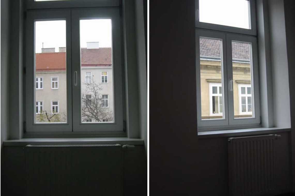
Abbildung 25: Sanierung Menzelgasse 17 – niedrigere Höhe der Fenster
