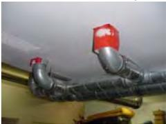
Gesicherte schalltechnische Entkopplung vom Bauwerk durch PE-Schläuche
