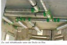
Zu- und Abluftkanäle unter der Decke im Flur
