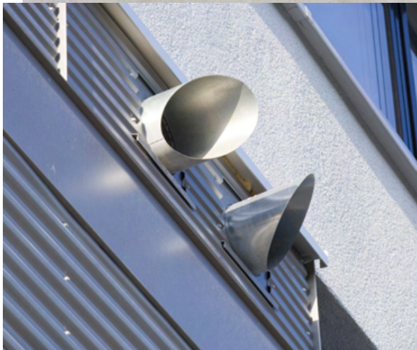
Office building Lu-teco, Ludwigshafen (D)
