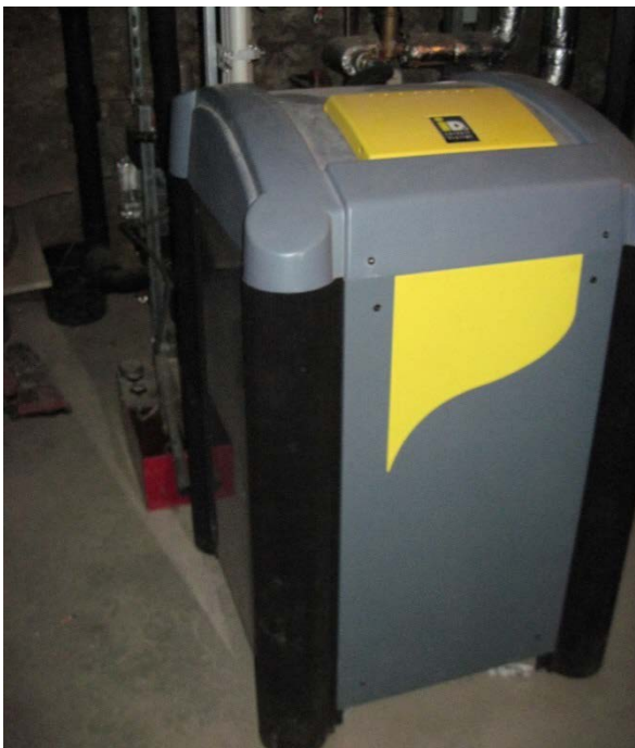
Abbildung 17 Links: Grundwasserwärmepumpe, Rechts: Förderbrunnen. Quelle: e7 Energie Markt Analyse GmbH
