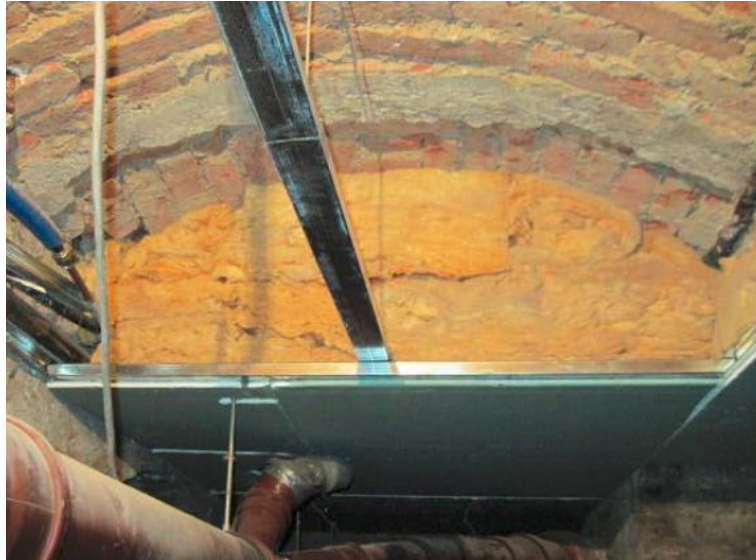
Abbildung 13: Eberlgasse, Dämmung Kellerdecke (Foto: e7 Energie Markt Analyse GmbH)
