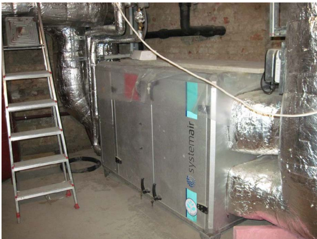
Abbildung 20 Zentrales Komfortlüftungsgerät im Haustechnikraum. Quelle: Andreas Kronberger
