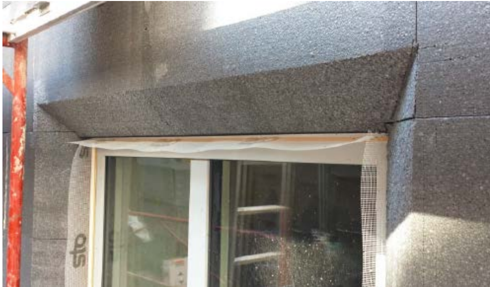
Abbildung 15: Eberlgasse, Fensterüberdämmung und Abschrägung der Leibung (Foto: Schöberl & Pöll GmbH)
