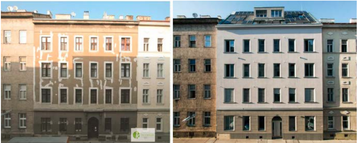
Abbildung 7: Straßenseitige Fassaden vor und nach der Sanierung (Foto: A. Kronberger)
