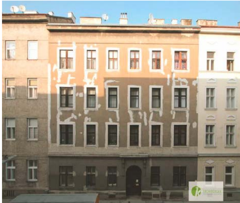
Abbildung 4: Straßenfassade vor Sanierung (Foto: A. Kronberger)
