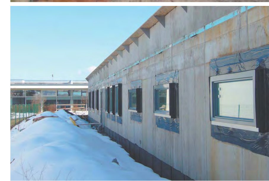
Versetzen Dreifach-Verglasung | Mounting of triple-glazing
