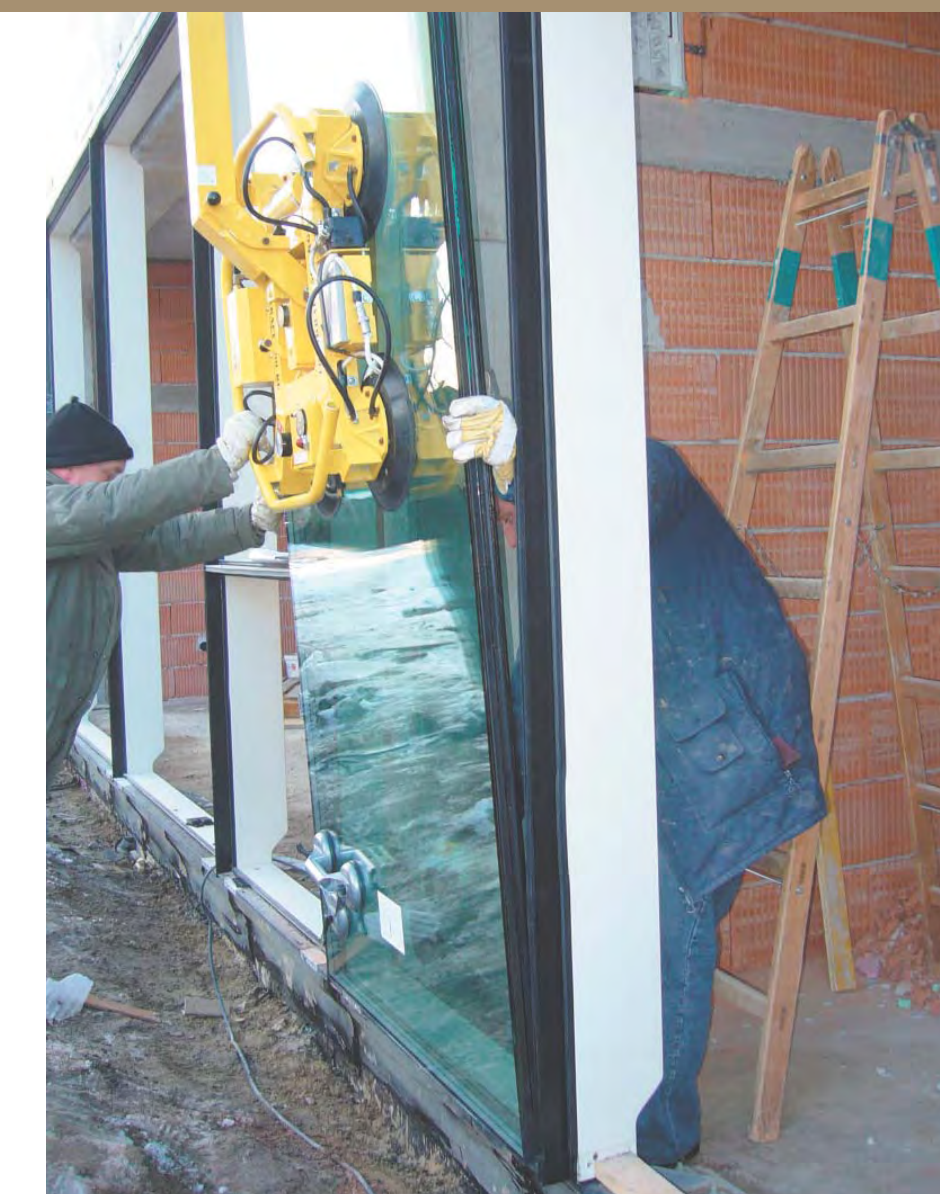
Versetzen Dreifach-Verglasung | Mounting of triple-glazing
