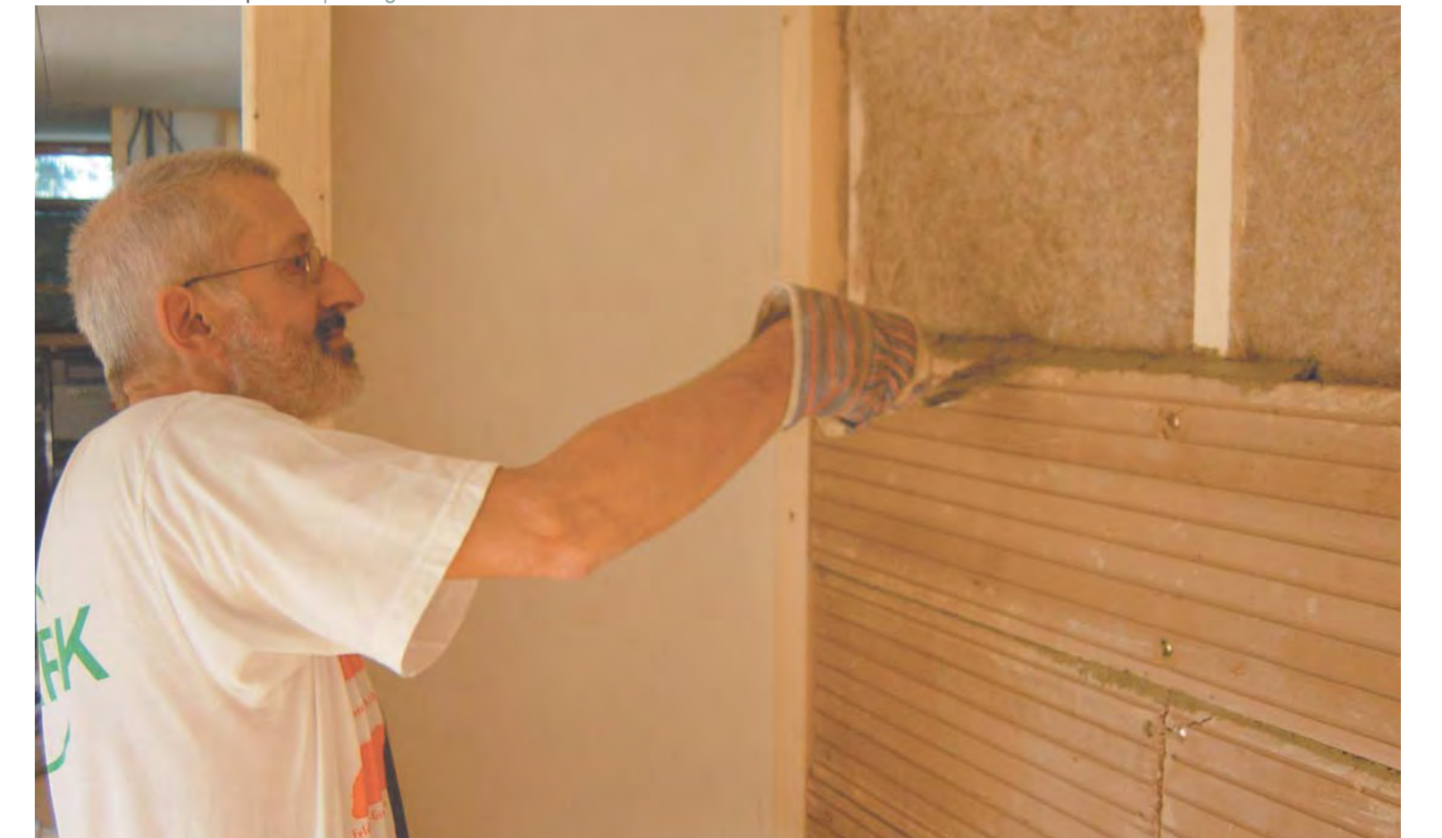
Versetzen der Lehmplatten | Fixing the loam slabs
