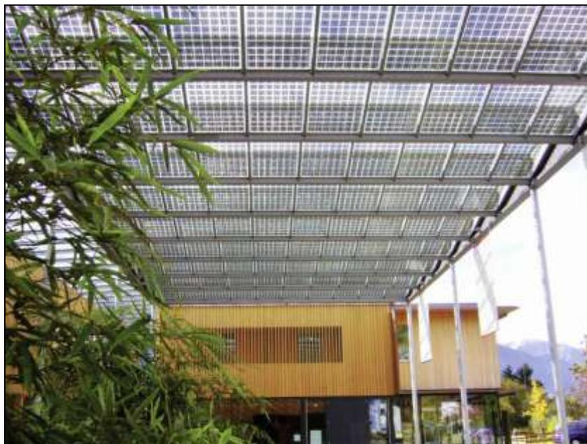
**Abbildung 45: Semitransparente Photovoltaik-Module (Ertex - Solar, 2009, 1)**
