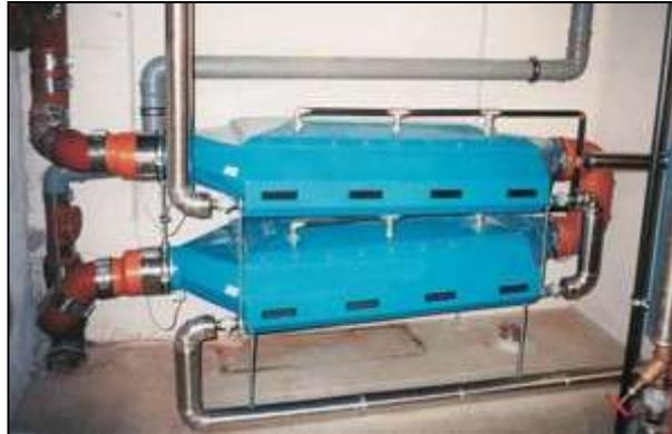
**Abbildung 42: Abwasser - Wärmetauscher zur zentralen Wärmerückgewinnung mit Reinigungssystem (Fercher, 2009, o.S.)**
