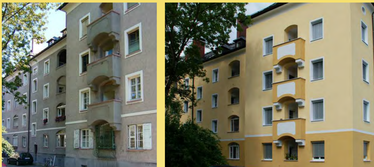
Die Fassade des Gebäudes in der Kuenburggasse wurde thermisch saniert und an die Fernwärmeversorgung der Stadt angeschlossen.
