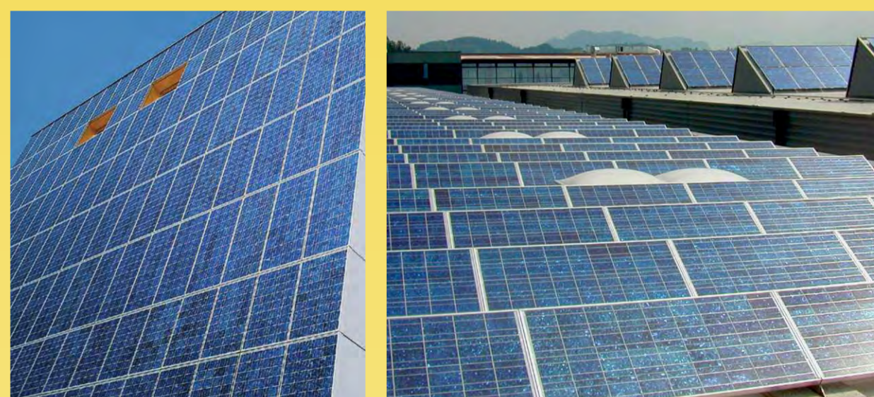
Stromproduktion durch Photovoltaik-Module an der Fassade oder am Dach.
