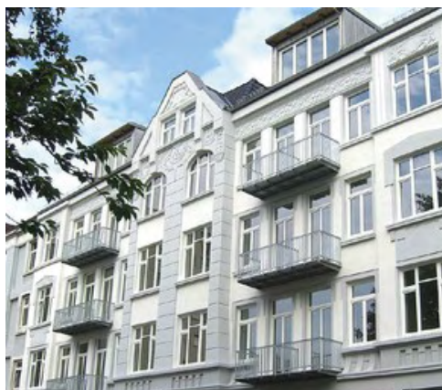
Abb.: Fertig renoviertes Gebäude Quelle: www.bine.info
