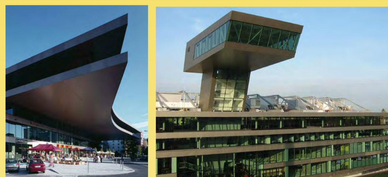
Warmwasseraufbereitung und Heizung erfolgen zum Teil durch thermische Solarkollektoren.
