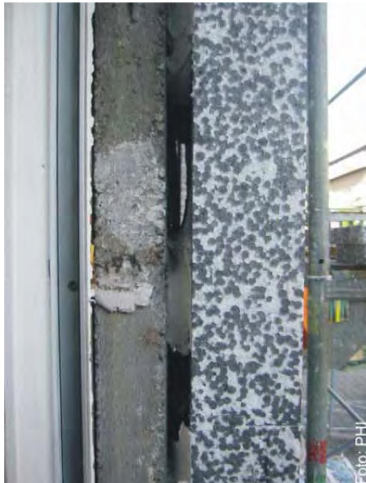
Abbildung 22 – ungewollte „Hinterlüftung“ der Dämmplatten durch nur punktuell angebrachte Klebestellen; Quelle: Passivhausinstitut
