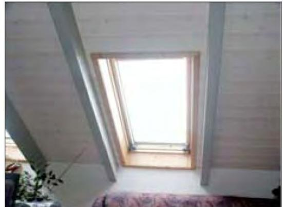
Abbildung 26 – undichtes Dachschrägenfenster (Kombination Blower-Door-Test und Thermografie); Bildquelle: Bundesverband für angewandte Thermografie Deutschland, [www.VaTh.de](http://www.VaTh.de)
