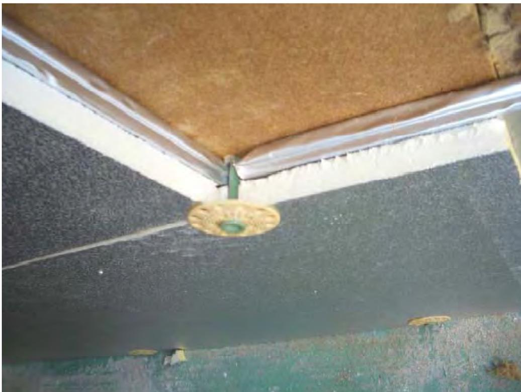
Abbildung 10: Mechanisch befestigte VIP-Dämmung mit PUR Lage (2-lagiger Aufbau); Bildquelle: A. Ferle, O.Essl; Endbericht „Praxis- und Passivhaustaugliche Sanierungssysteme für Dach und Wandbauteile unter Verwendung von Hochleistungsdämmsystemen“, Haus der Zukunft, 2006
