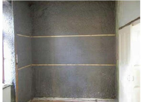
Abbildung 28: Aufsprühvorgang der Zellulosedämmung und fertige Innendämmung mit Abzugsleisten (Quelle: Kautsch e.a., Endbericht des Haus der Zukunft Projekts „Zellulose-Innendämmung ohne Dampfsperre“, 2006,
