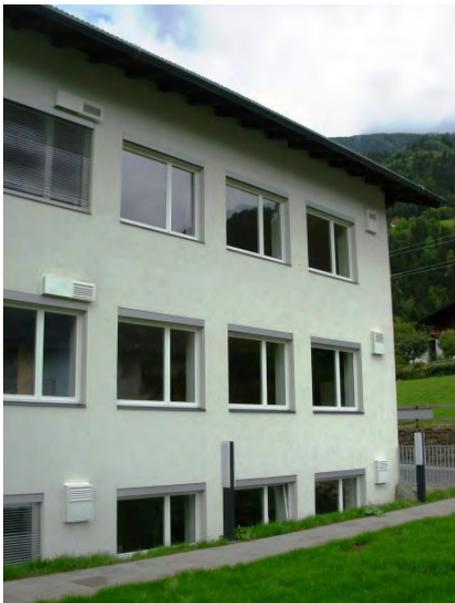
Abbildung 7: Beispiele einer dezentralen Anordnung der Außenluft/Fortluft (Schule Ainet Osttirol)
