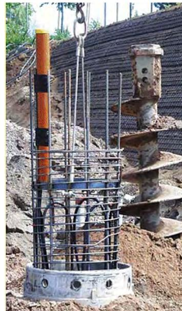
Abbildung 10: Energiepfahl vor dem Einbetonieren<sup>25</sup>
