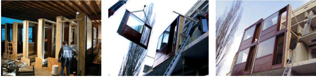
Abbildung 43: Elemente von Vorhangfassaden
