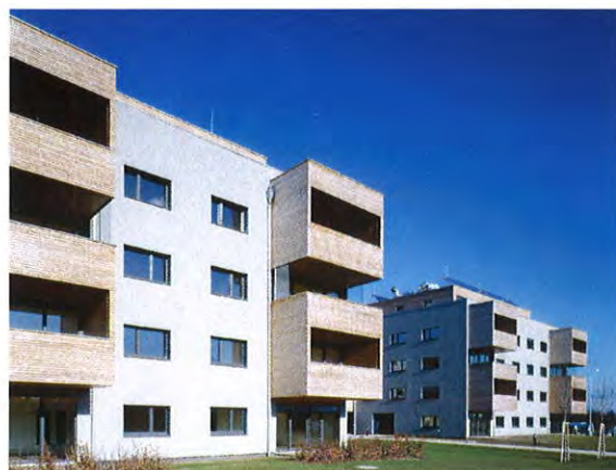
Abbildung 1: Passivhausssiedlung Mühlweg (Quelle: Bruno Klomfar)
