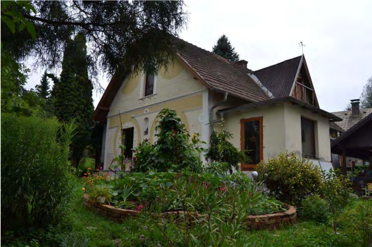
Thermische Sanierung eines Einfamilienhauses aus dem Jahr 1912 im Rahmen eines dreitägigen Workshops im Neulengbach mit einer vorgesetzten Fassade mit Hilfskonstruktion und anschließender Verplankung mit Fermacell-Platten.
