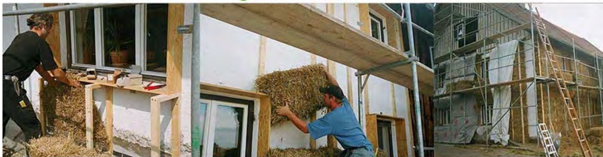
Strohballenbau-Konstruktion 8: thermische Sanierung einer Fassade, Fotos: baubiologie.at
