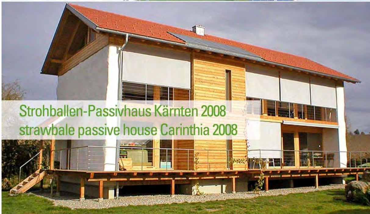
Beispiel: Errichtung des Strohballenhauses in St. Donat mit vorgesetzter Strohballen-Fassade. Fotos: Horst Danner
