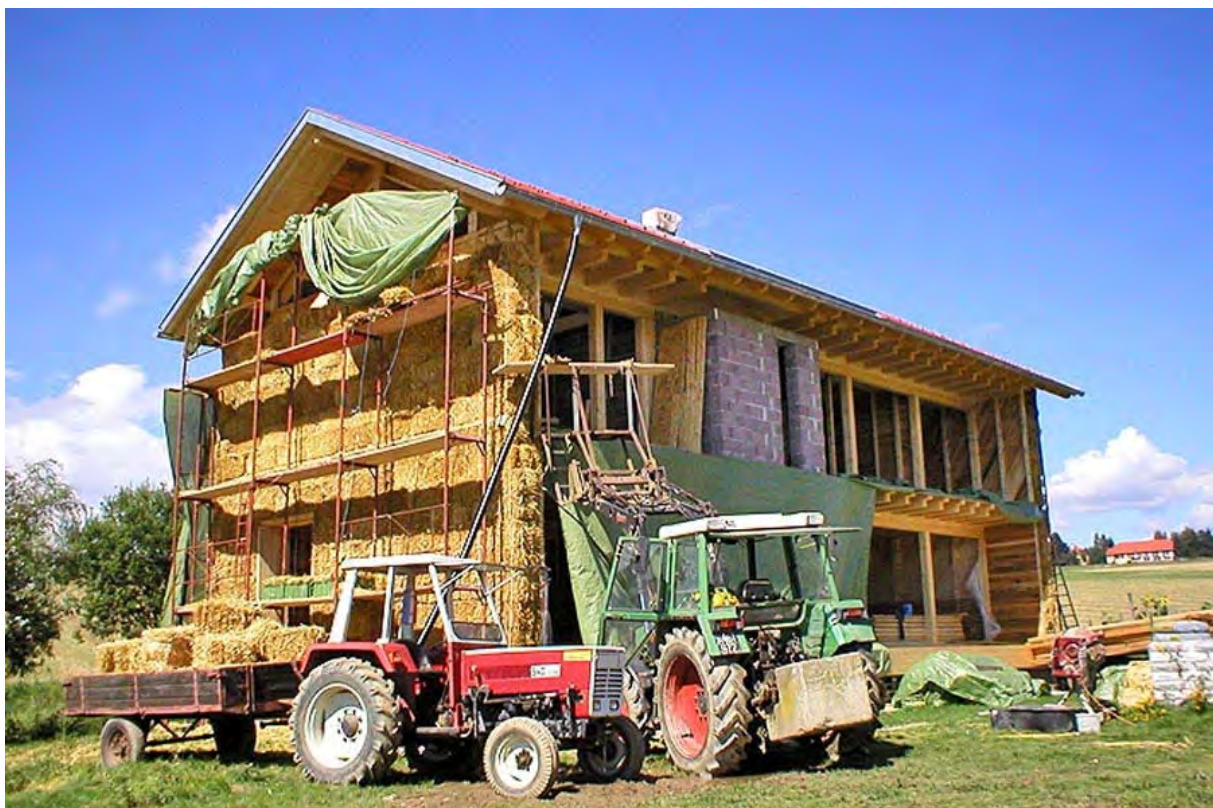
Beispiel: Errichtung des Strohballenhauses in St. Donat mit vorgesetzter Strohballen-Fassade. Fotos: Horst Danner
