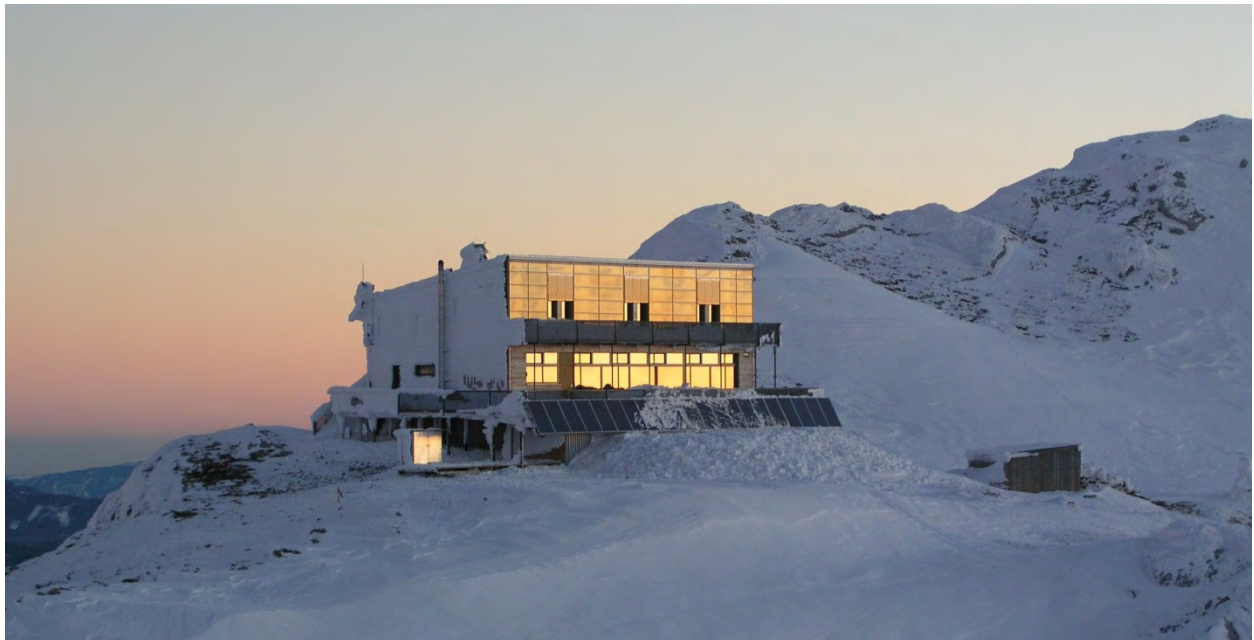
Abbildung 7: Das Schiestlhaus am Hochschwab erreicht trotz extremer klimatischer Bedingungen auf 2.145 m Seehöhe nicht nur Passivhausqualität, sondern ist weitgehend energieautark. (© Resch ÖTK)
