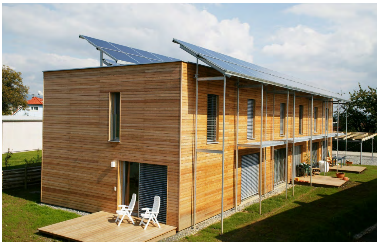
Abbildung 4: Plusenergie-Reihenanlage in Weiz in der Steiermark. Die 24 Holzfertigteilegebäude wurden in Passivhausqualität ausgeführt. Sie decken mit ihrer über 1000 m 2 großen PV-Anlage nicht nur den Eigenbedarf an Strom, sondern erwirtschaften über 1 Jahr bilanziert sogar einen Überschuss. (© ARCH° BUERO KALTENEGGER)
