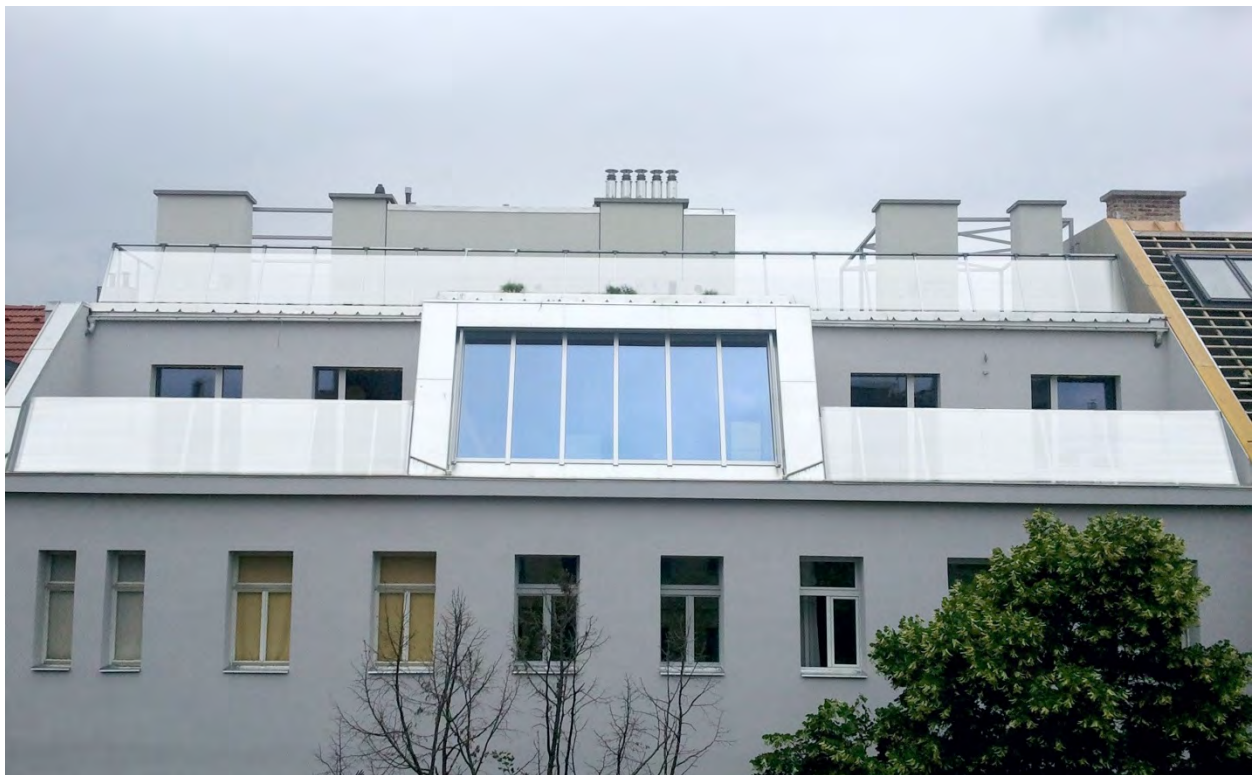
Abbildung 3: Plus-Energie-Dachgeschossausbau eines typischen Wiener Gründerzeithauses in der Ybbsstraße in Wien. Das Projekt soll die Anwendbarkeit des Plus-Energie-Konzeptes auf Dachgeschoßausbauten von Gründerzeithäusern aufzeigen. (© Schöberl und Pöll GmbH)
