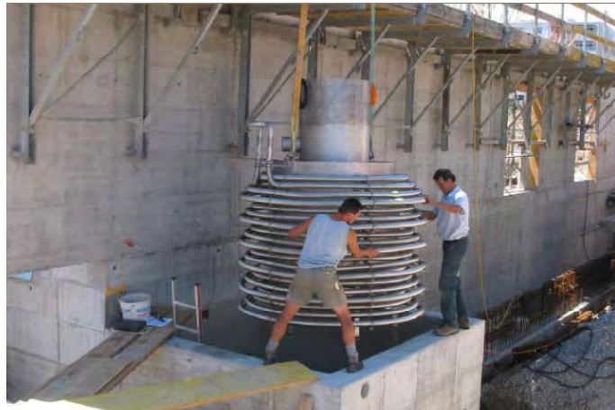
Abbildung 3.8: Abwasserschacht einer Wohnüberbauung (Feka, 2009)
