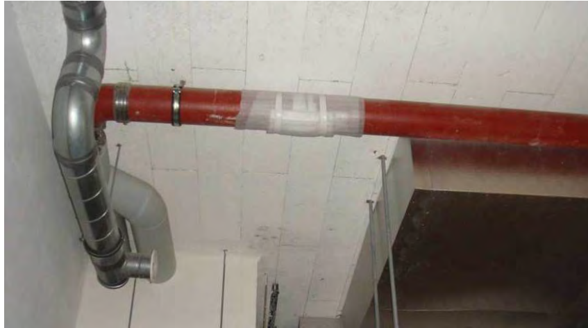
Abbildung 3.26: Position des Temperaturmesspunktes an der Sohle des waagrecht Abwasserrohres (Sammelstrang der sechs Wohneinheiten)
