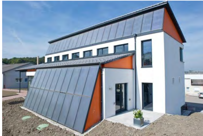
Abbildung 43: Südostansicht Sonnenhaus Eferding
