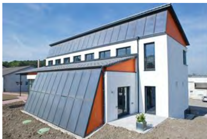
Abbildung 3: Außenansicht Vital-Sonnenhaus Eferding mit Dach- und Wandkollektoren
