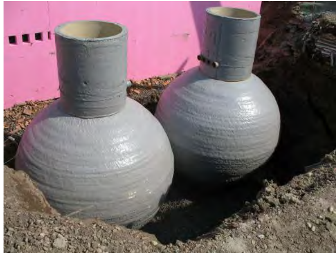
Abbildung 12: Kugeltanks vor dem Einbau ins Erdreich
