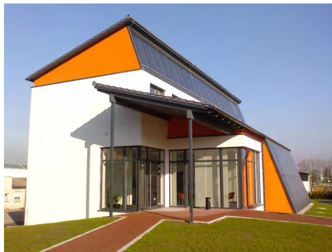
Abbildung 44: Südwestansicht Sonnenhaus Eferding
