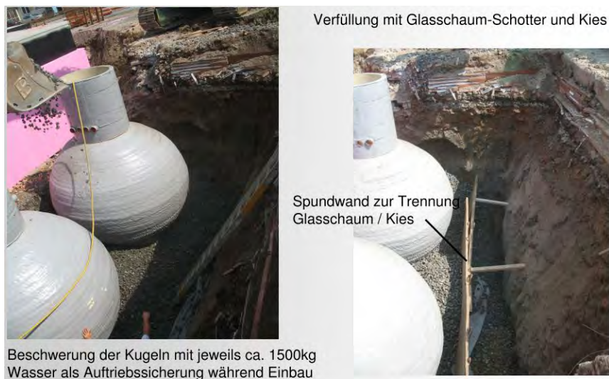
Abbildung 13: Einbau der Kugeltanks ins Erdreich
