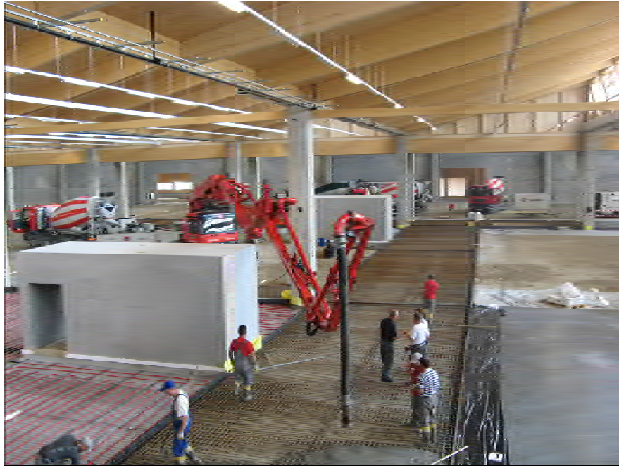
Bild 1: Verlegung der Rohrschlangen zur Errichtung des Erdspeichers.
