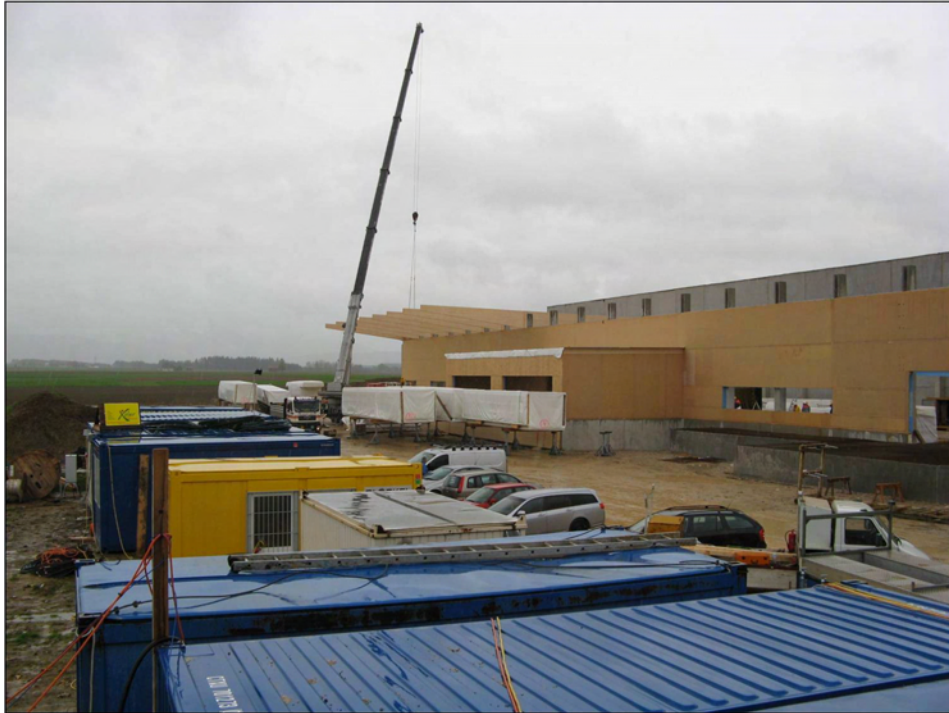
Bild 3: Holzelemente und Anlieferboxen in Passivhauskonstruktion
