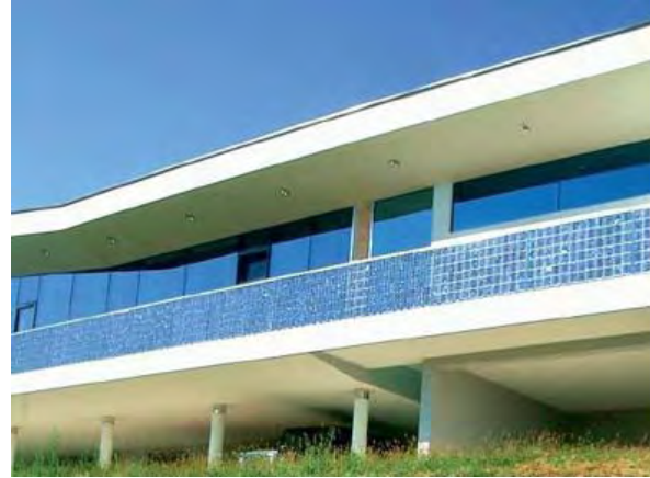
Abbildung 27: Balkongeländer mit PV-Modulen © ertex solar
