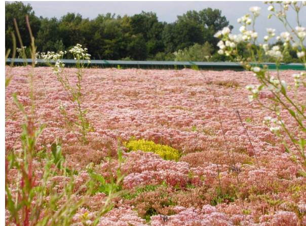
Abbildung 54: Textil Linz Wiener Straße, Quelle: www.gruendach.at
