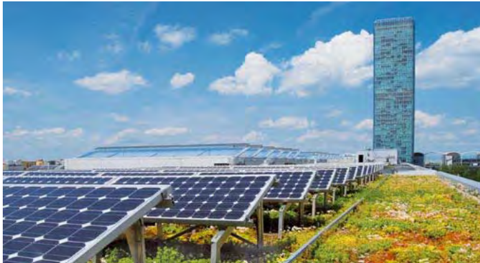
Abbildung 56: Dachbegrünung mit PV © Zinco
