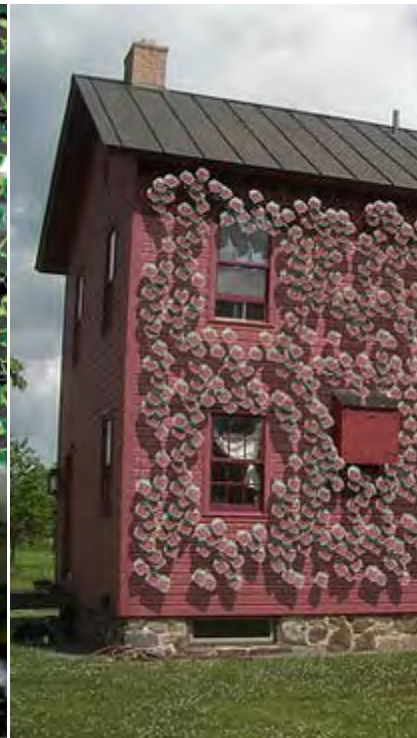
Abbildung 51: Solar Ivy braun auf der Fassade © SMIT
