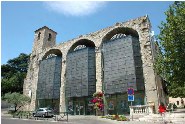
Abbildung 3a und 3b PV in historischen Bauten
