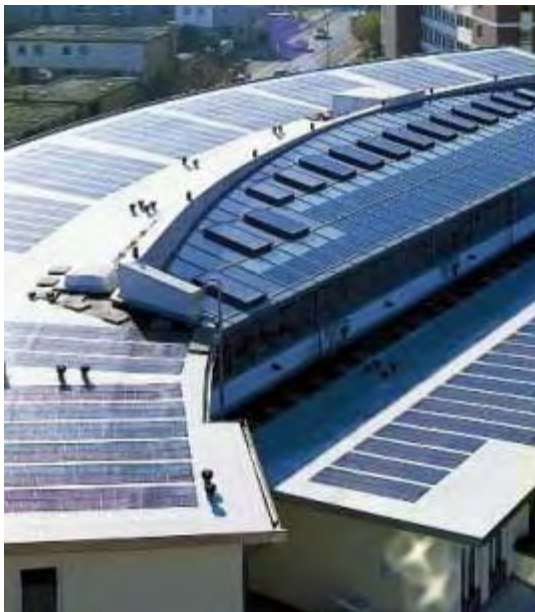
Abbildung 36: Flachdach mit Solar-Dachbahnen, Wohnanlage Braunschweig © alwitra GmbH & Co.
