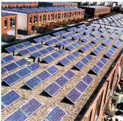
Abbildung 1a und 1b PV Aufdachlösungen
