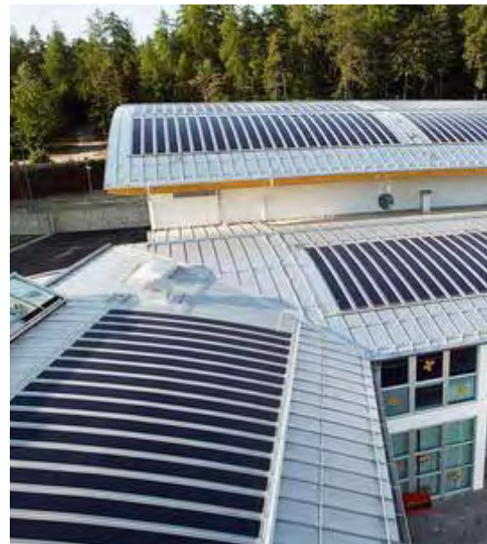
Abbildung 37: Aluminium Stehfalzdächer mit integrierter PV © PREFALZ Solar
