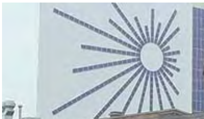
Abbildung 4 Das Kraftwerk Simmering
