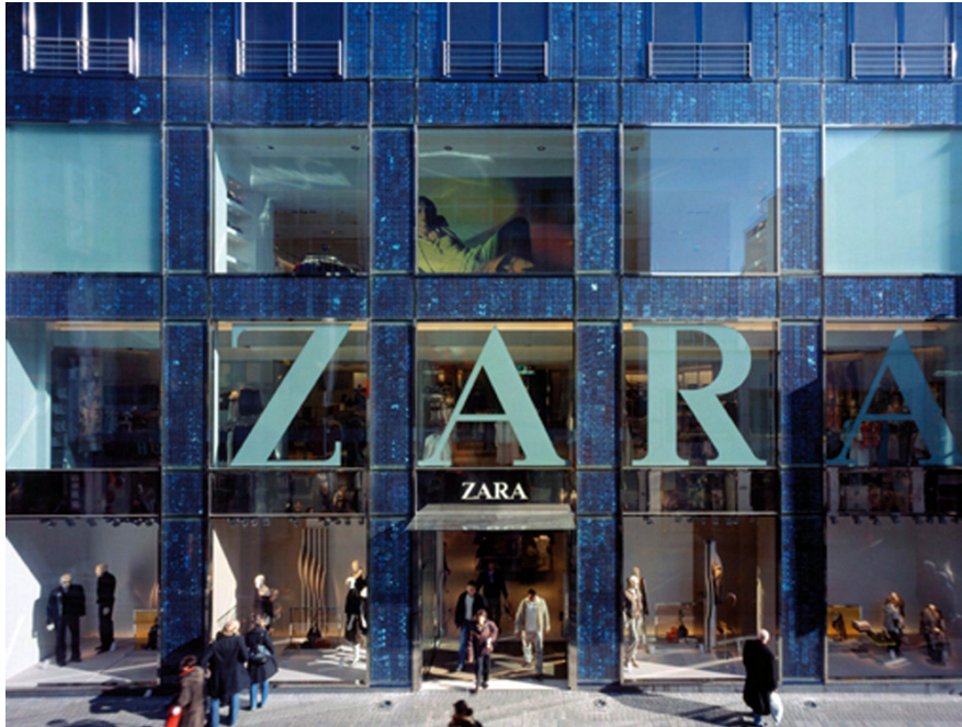
Abbildung 20: Photovoltaik-Warmfassade ZARA Fashionhouse, Köln © Hilber Solar
