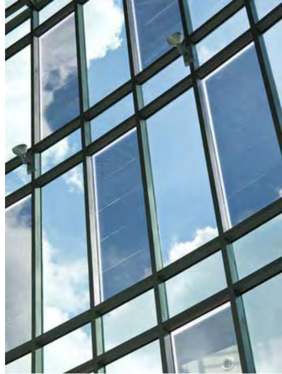
Abbildung 18: Fassade des Schott Headquarters in Mainz mit ASI® Dünnschichtmodulen © SCHOTT AG
