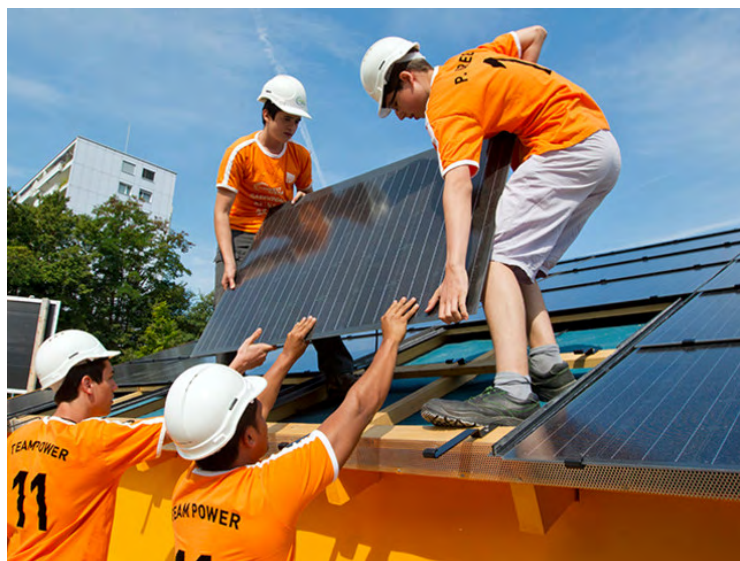
Abbildung 28: Verlegung von rahmenlosen Indach-Modulen © MegaSlate® Solardachsystem
