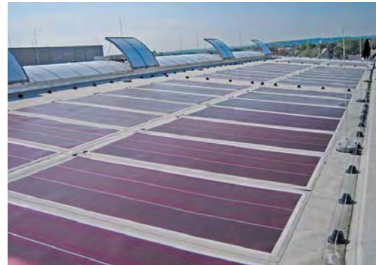
Abbildung 35: Verlegtes Dach Austroplan PV-Liner © AGRU
