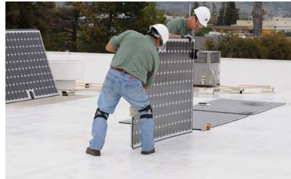
Abbildung 31: Verlegung der Module © Lumeta
