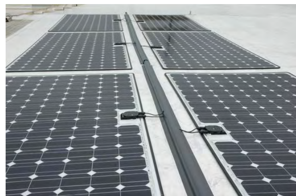
Abbildung 33: Geklebte PV-Module auf dem Flachdach © Lumeta
