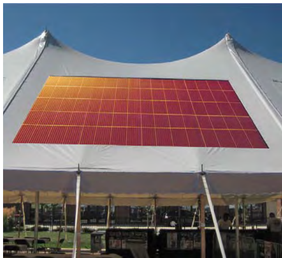
Abbildung 57: Solare Energieerzeugung auf weichen, beweglichen Strukturen © Power Plastic
