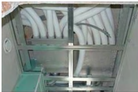
Abbildung 28: ungünstige, enge Einbausituation, kein Trockenbau-Revisionstüren vorgesehen
