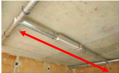
Abbildung 26: nicht reinigbarer Abschnitt
