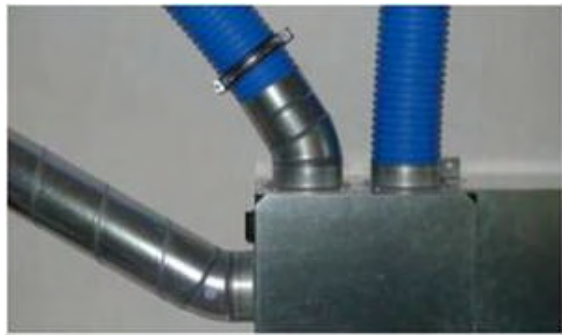
Abbildung 30: alle Anschlüsse für Spiro- und Kunststoffrohre DN 125
