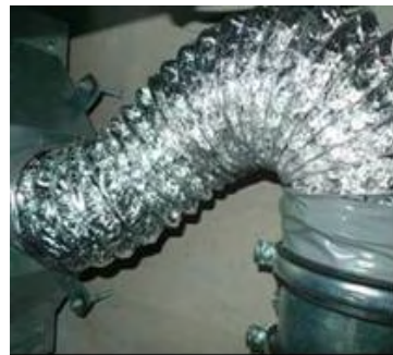
Abbildung 13 und 14: nicht zulässige Folienschläuche, Innen- und Außenansicht
