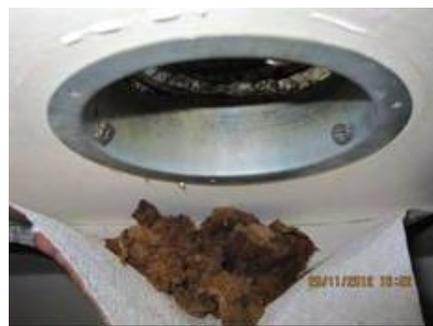
Abbildung 3 und 4: typische Ablagerungen in Abluftleitungen nach mehrjährigem Betrieb
