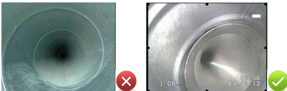
Abbildung 1 und 2: Zuluftleitungen mit grenzwertiger und akzeptabler Sauberkeit
