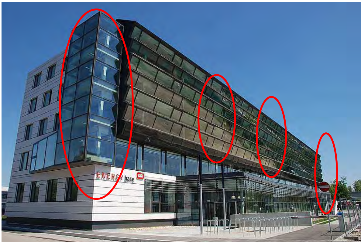
Abbildung 14: Position Pflanzenpuffer ENERGYbase, Quelle: www.caliqua.at
