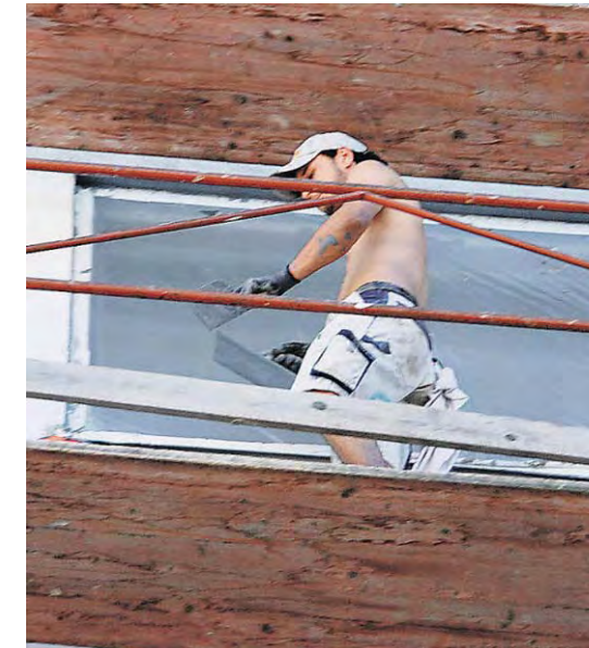
Neben der Architektur bot der Tag der offenen Baustelle auf dem Stadtwerke-Areal auch etwas andere Reize fürs Auge.
