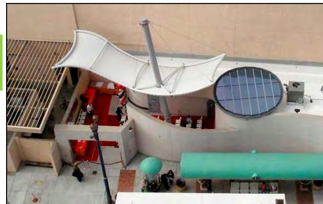
Glasdach oder textile Überdachung
