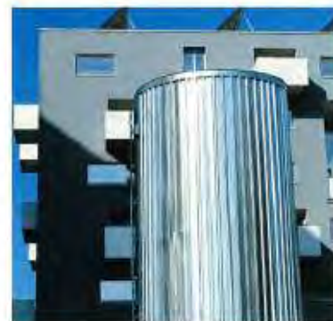
200.000 Liter von der Solaranlage bis auf 90 Grad Celsius aufgeheiztes Wasser kann im größten Pufferspeicher Salzburgs gesammelt werden.
