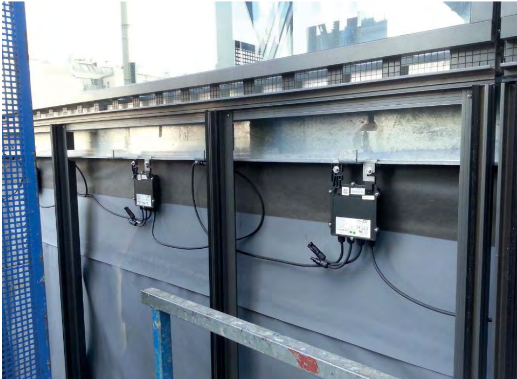
Abbildung 88: Leistungsoptimierer – Anordnung in der Fassade (Quelle: Schöberl & Pöll GmbH)
