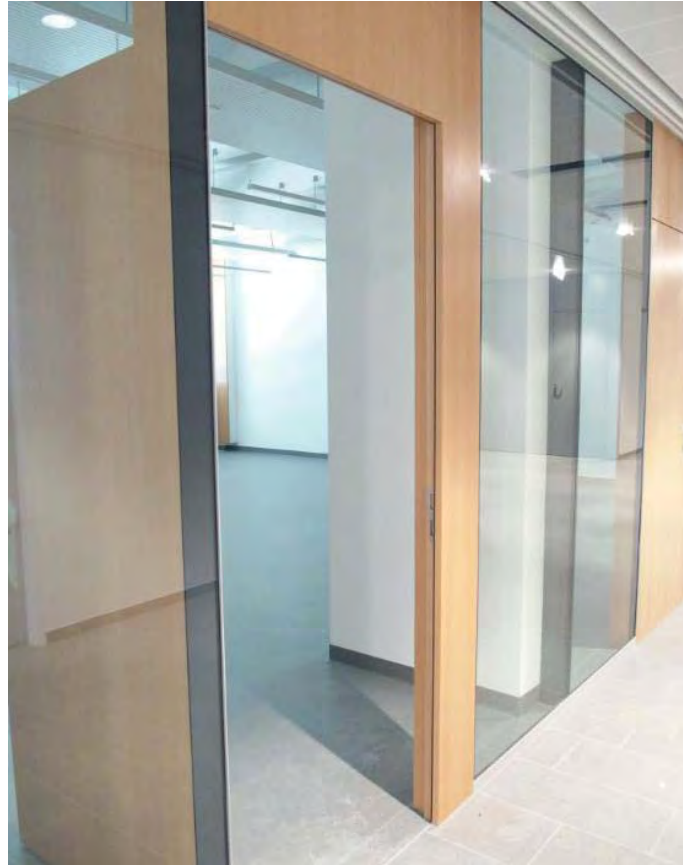
Abbildung 33: Glastrennwände (Foto: Schöberl & Pöll GmbH)
