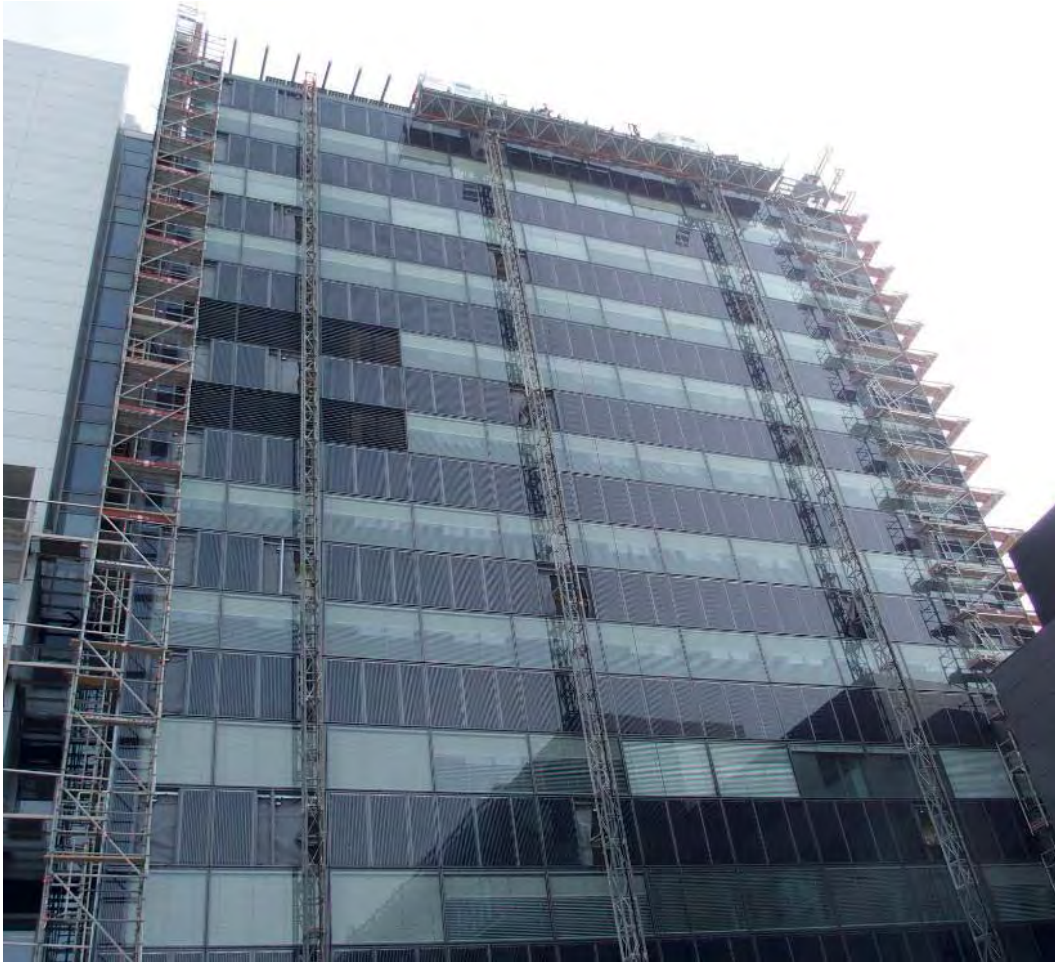
Abbildung 83: Fotovoltaikanlage in der Süd-Fassade (Foto: Schöberl & Pöll GmbH)
