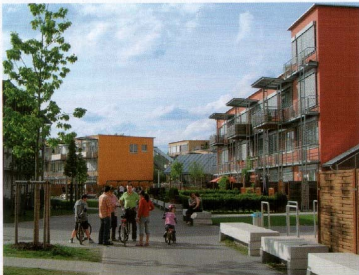
Abb. 3: EBS-Wohnhausanlage in der solarCity Linz
