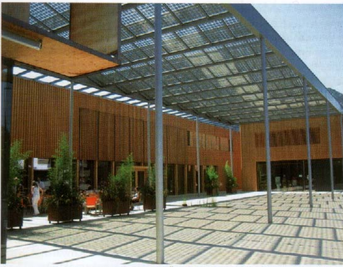
Abb. 4: Transuzente und multifunktionelle Überdachung des Vorplatzes (Ertex Solar)
