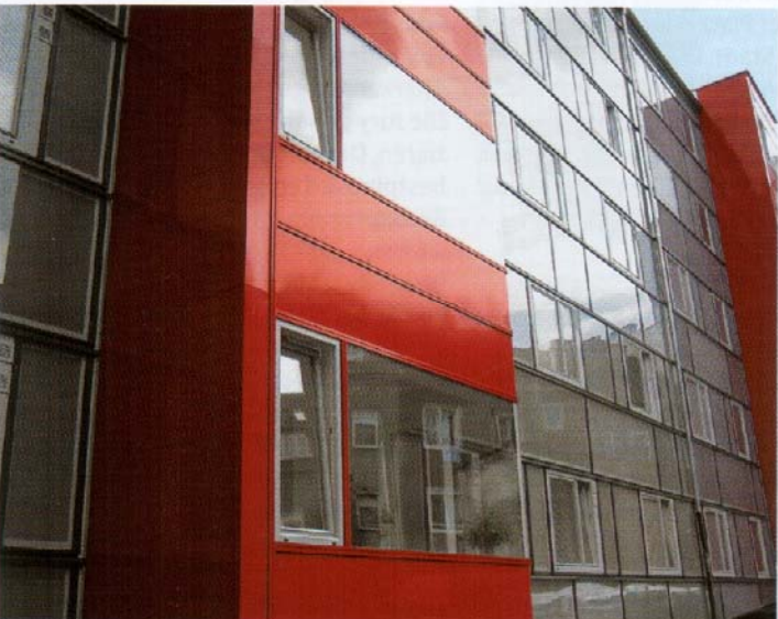
Abb. 5: Balkonvergrößerung und Verglasung
