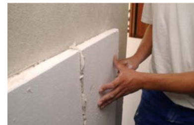
Innendämmung mit Calciumsilikatplatten
