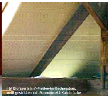
n&l Biofaserlehm®-Platten mit fertig zugiehbaren, glatter Lehm-Oberfläche in natürlichen Farben
