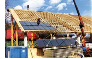
Bild 3: Montage von Großflächen-Kollektormodulen in Eisibswald (Foto: SOLID)
