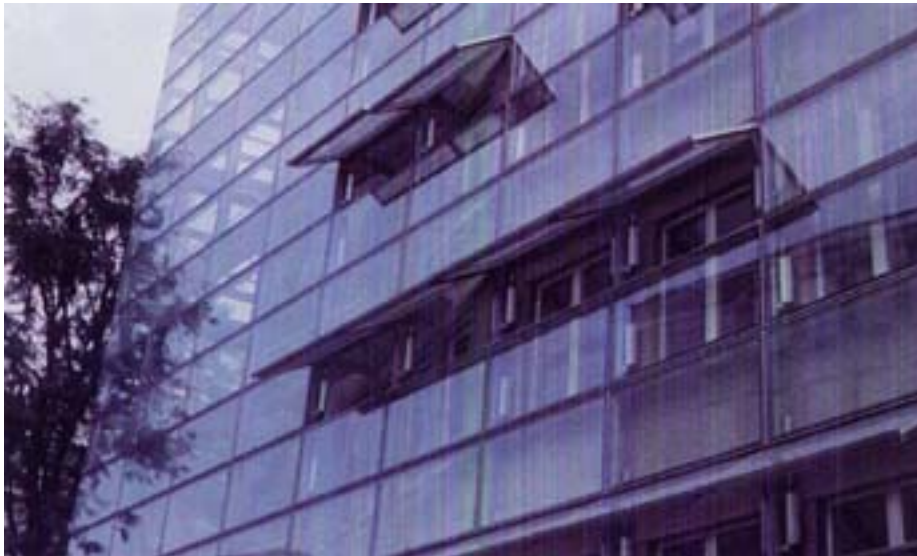
Abb. 28 , Beispiel Suva-Gebäude, Architekten Herzog & de Meuron
