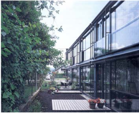
Abb. 87 thermisch optimierte Fassade
