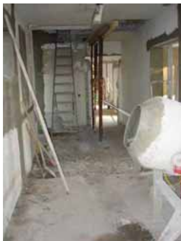
Nach Entfernung von Eternitdach, Dachstuhl und den tragenden Wänden im Eingangsbereich wurden die bestehenden Deckenelemente durch Deckenuntersicht ebene Überzüge statisch abgefangen.
