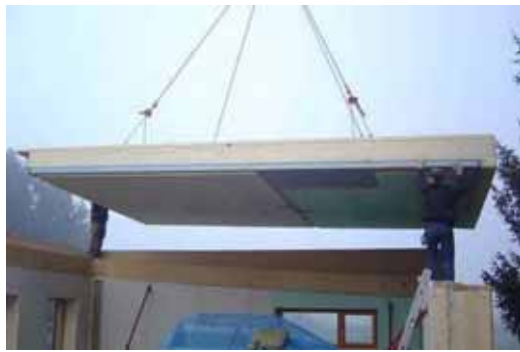
Die 132 m 2 große Pultdachkonstruktion ist aus lediglich 4 Einzelementen gefertigt.
