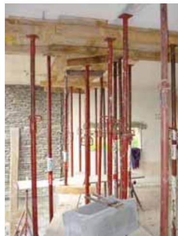
Nach Entfernung von Eternitdach, Dachstuhl und den tragenden Wänden im Eingangsbereich wurden die bestehenden Deckenelemente durch Deckenuntersicht ebene Überzüge statisch abgefangen.
