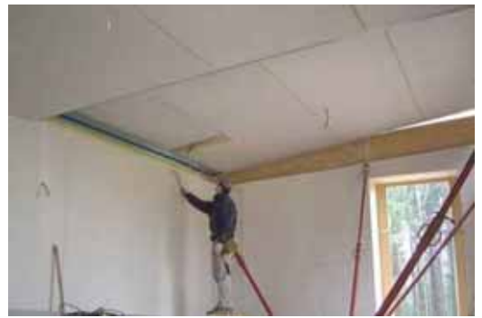
Die 132 m 2 große Pultdachkonstruktion ist aus lediglich 4 Einzelementen gefertigt.
