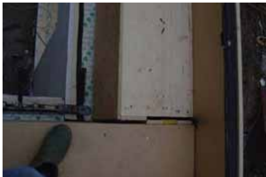
Anbringen der Lippendichtungen auf den Dachauflagern
