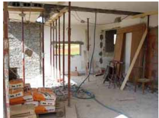
Der Wohnraum wurde mittels Auswechslung über die Südecke möglichst großzügig geöffnet.
