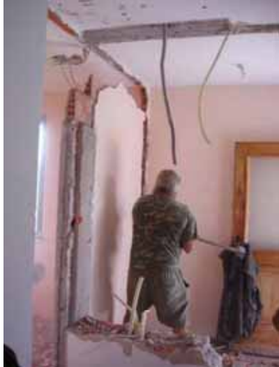
Abriß aller nicht tragenden Zwischenwände zur Schaffung größerer Raumeinheiten
