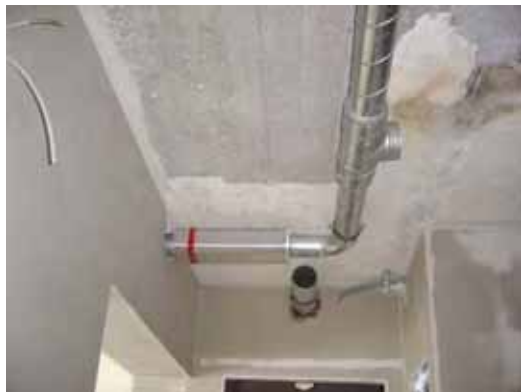
Ausschnitt aus der detaillierten Lüftungsleitungsführung
