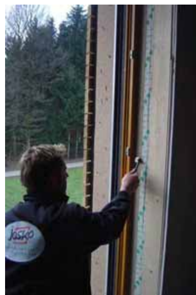
Luftdichter Einbau der Fenster in die Holzriegelkonstruktion der Aufstockung
