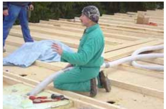
Einblasen der Zellulosedämmung
