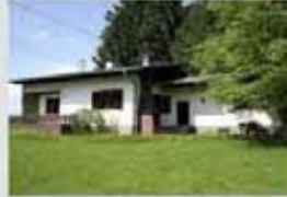
Bild 2: Arbeitsfeld vor Sanierungstätigen
