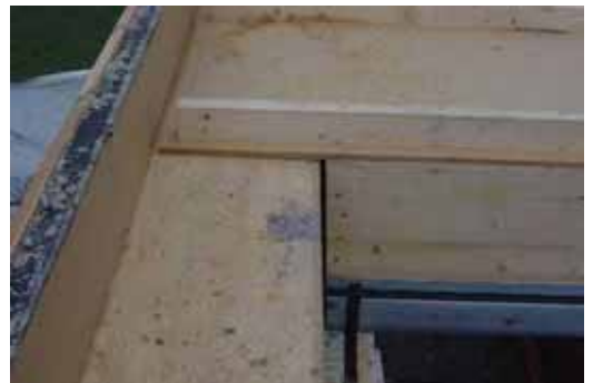
Anbringen der Lippendichtungen auf den Dachauflagern
