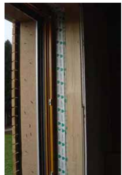
Luftdichter Einbau der Fenster in die Holzriegelkonstruktion der Aufstockung
