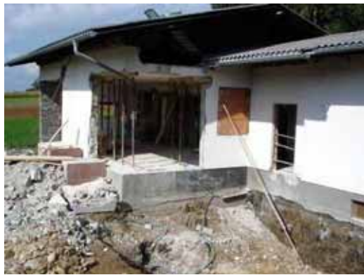
Der Wohnraum wurde mittels Auswechslung über die Südecke möglichst großzügig geöffnet.
