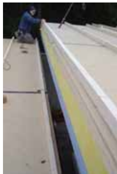
Luftdichter Anschluß der Elementstöße
