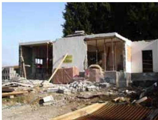
Nach Entfernung von Eternitdach, Dachstuhl und den tragenden Wänden im Eingangsbereich wurden die bestehenden Deckenelemente durch Deckenuntersicht ebene Überzüge statisch abgefangen.
