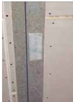
Luftdichter Anschluß der Elementstöße
