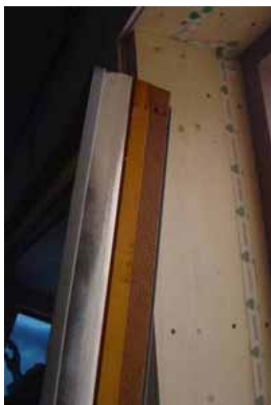
Luftdichter Einbau der Fenster in die Holzriegelkonstruktion der Aufstockung
