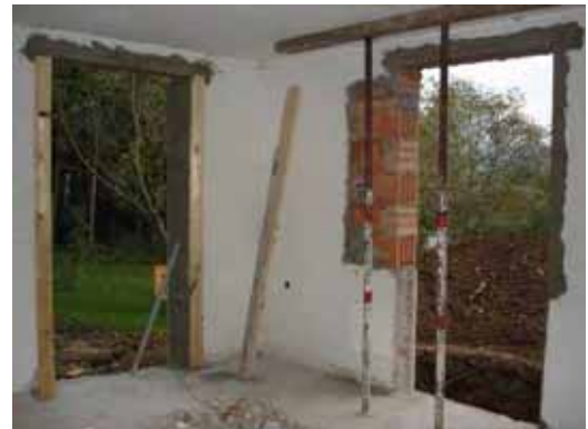
Oben: Durch Entfernen der Parapete raumhohe Fenster für mehr Tageslicht. Unten: Aus den zuvor zwei Schlafräumen, einem Wohnzimmer, Windfang und ...
