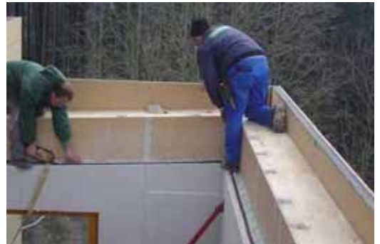
Anbringen der Lippendichtungen auf den Dachauflagern
