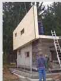
Bild 3: Beginn der Montage der vorgefertigten Holzelemente als Themenhülle
