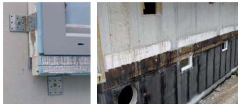
Abb. 14 (ganz links): Wohnbau Utendorfsgasse, Befestigung der Fenster vor der Fassade. Abb. 15 (links): Thermische Entkopplung des Fußpunktes des Gebäudes.
