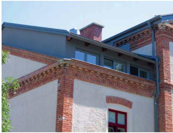
Abb. 9: Angehobenes Dach und Dachgeschoßaufbau. Foto: Haselsteiner
