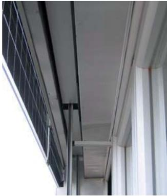
Abb. 6, 7: Photovoltaikfassade, CLIP-ON Befestigungsdetails. Fotos: Edeltraud Haselsteiner
