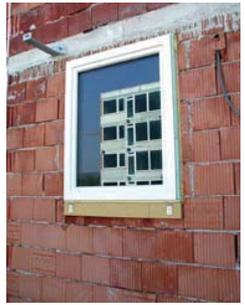
Abb. 6: Einbau der Passivhausfenster und thermische Trennung der Vordachverankerung
