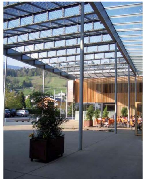
Abb. 13: Transluzente Fotovoltaikanlage, überdachter Dorfplatz. Foto: Edeltraud Haselsteiner
