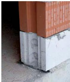
Abb. 11: Gasbetonsockel beim Ziegelmauerwerk
