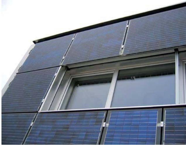
bäude SOL4 der Stromertrag aus der PV-Anlage über das Kalenderjahr in etwa den Heizenergiebedarf deckt, handelt es sich um ein Null-Energie-Bürohaus. Eine thermische Solaranlage mit 36 Quadratmetern Kollektorfläche garantiert eine nahezu 100-prozentige Deckung des Warmwasserbedarfs im Sommer.
