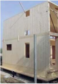
Abb. 6: Massivholz-Plattenkonstruktion als Innenhülle
