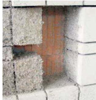
Abb. 8, 9: Aufgespritzte Zellulosedämmung, herausgetrennte Prüfkörper. Fotos: Michael Mandel (4)
