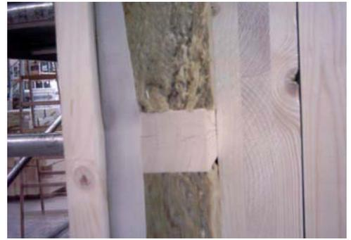
Abb. 6: KLH-Wandaufbau: KLH-Mineralfaser-Winddichtung-Lattung (Hinterlüftungsebene). Foto: Kulmer
