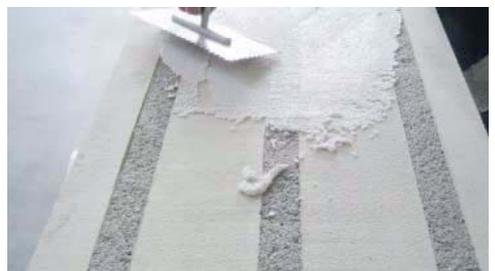
Abb. 13: Prototyp des aufgespritzten und verputzten Zellulose-Schlitzabsorbers
