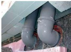
Abb. 9: Führung der Solarleitungen in der Außenwand
