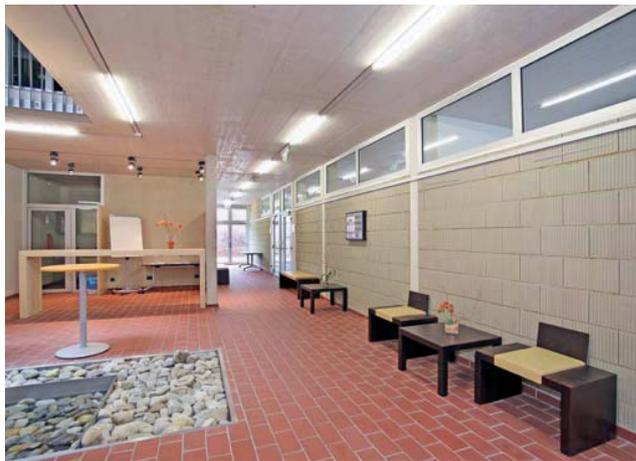
Abb. 4: SOL4, Innenräume mit unverputzter Lehmziegelwand. Foto: Office design
