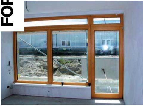
Abb. 4: solarCity Linz: Verglasung mit TWD Element
