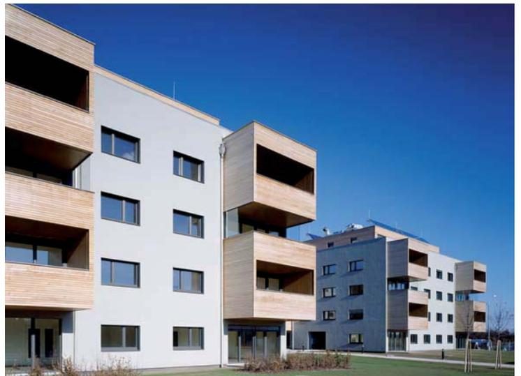
Abb. 2: Haus am Mühlweg – Passivwohnhaus in Holzmischaufbauweise, Wien; Arch. Dietrich | Untertirfeller
