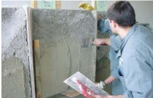
Abb. 7: Aufbringen einer Putzschicht auf aufgespritzter Zellulosedämmung
