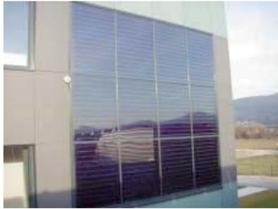
Abb. 10–11: Montage von Fassadenkollektoren der Test-fassade einer Massivwand. Fotos: GREENOneTEC
