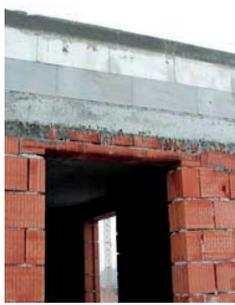
Abb. 7: Attikaausführung mit Gasbetonsteinen. Fotos Wilhelm Hofbauer (7)
