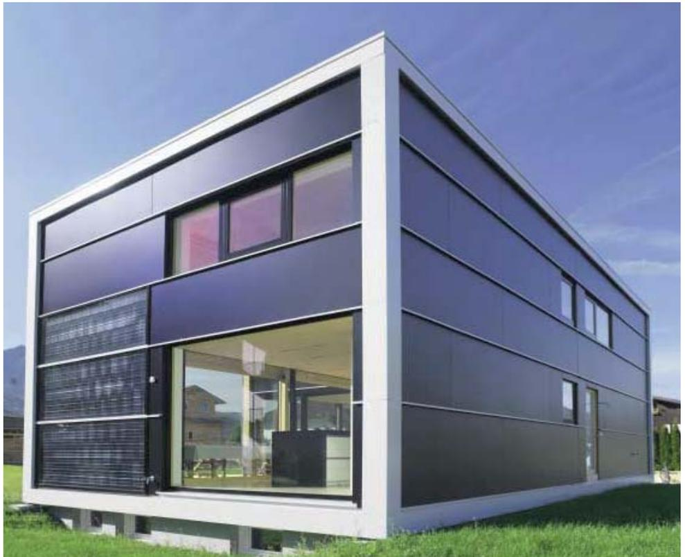
Abb. 1: Architekten Achammer & Partner, Einfamilienhaus mit integriertem Großflächenkollektor, Nenzing. Foto: AKS Doma Solartechnik
