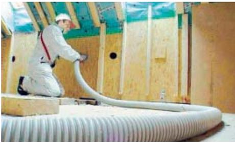
Abb. 10, 11: Eingeblassene Zellulosedämmung, Wand und Dach. Fotos: ThermoFloc (2)
