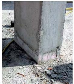
Abb. 10: Fußpunkt Stahlbetonpfeiler mit Isokorb und Wärmedämmung
