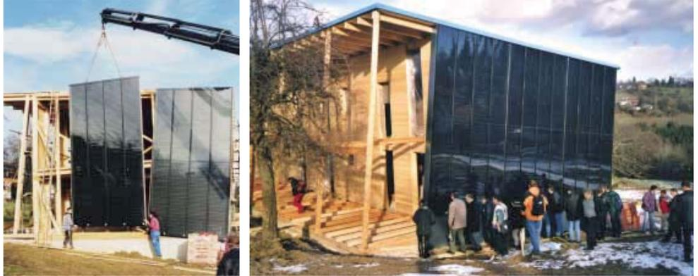
Abb. 8 – 9: Montage von Fassadenkollektoren der Testfassade einer Holzständerkonstruktion. Fotos: Bergmann/AEE INTEC
