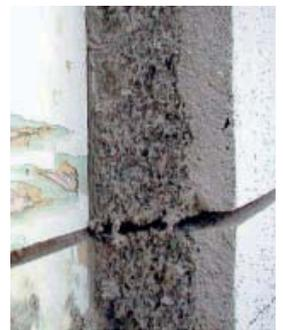
Abb. 9: Schnitt durch das Innendämmsystem: Tragfähige Putz- und Farbschichten wurden vor dem Aufbringen der Zellulosedämmung nicht entfernt. Foto: TU Graz
