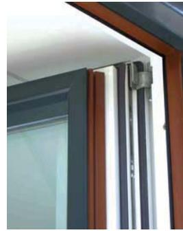
Abb. 14, 15: Geprüftes Passivhaus-Fensterprofil. Fotos: Hackermüller
