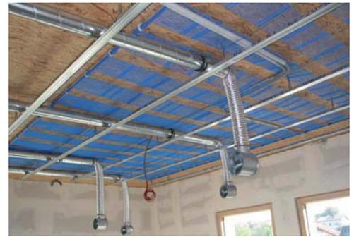
Abb. 8-10; Konstruktion der Rundholzstützen, Außenwände und Decken Abb. 11; Heiz-/Kühlflächen an der Decke mit Lüftungsrohren. Fotos: BBM
