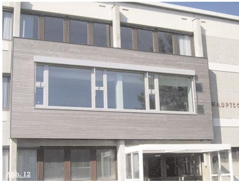
Abb. 11, 12: Passivhaus-Schulsanierung in Schwaneinstadt: Montage der vorgefertigten Holzrahmenelemente an der bestehenden Fassade und Zubau. Fotos: Günter Lang
