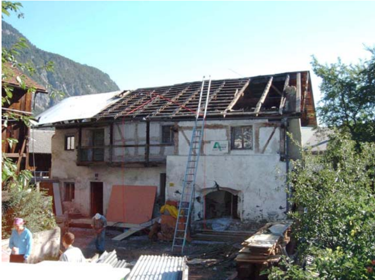
Abriss des alten Dachstuhl
