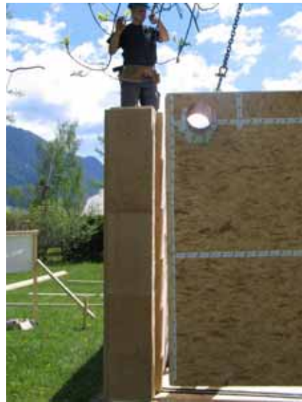
Abbildung 7 – Zusammenfügen zweier Wandbauteile
