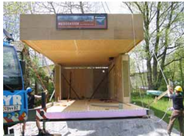
Abbildung 13 – Versetzen des Dachelementes
