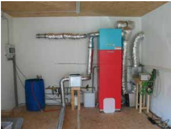
Abbildung 20 – Wohnraum- Lüftungsanlage
