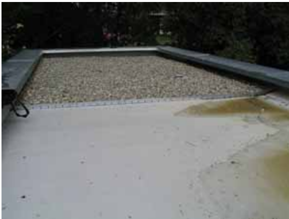
Abbildung 18 – Dacheindeckung mit Kies- bzw. Foliendach
