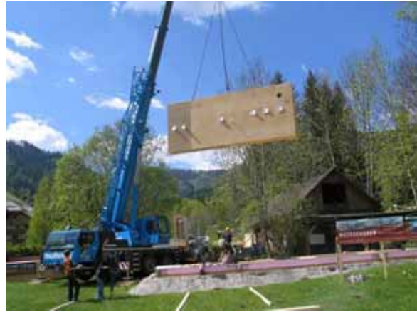
Abbildung 5 – Einheben eines Wandbauteiles
