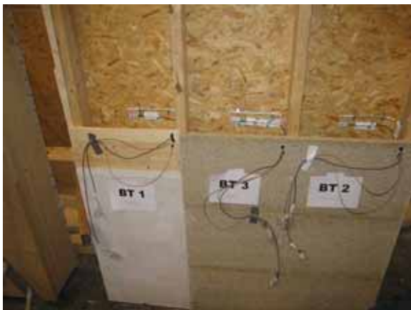
Abbildung 58 – Ansicht des Wandelementes nach Einbau der Messtechnik
