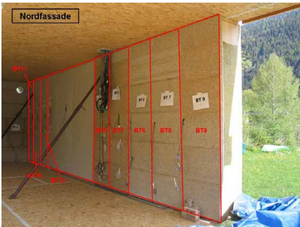
Abbildung 55 - Innenansicht Nordfassade mit untersuchten Wandaufbauten im Bauzustand
