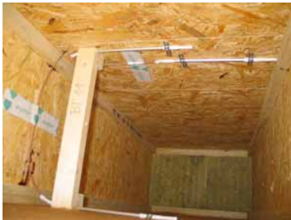
Abbildung 143 – Einbau der kombinierten Temperatur- und Feuchtesensoren
