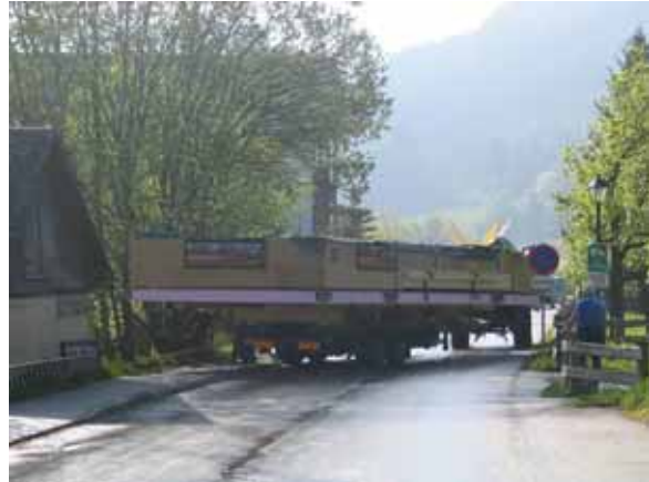
Abbildung 3 – Anlieferung des Boden- und Dachelementes
