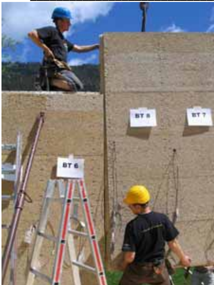
Abbildung 10 – Versetzen eines Wandelementes
