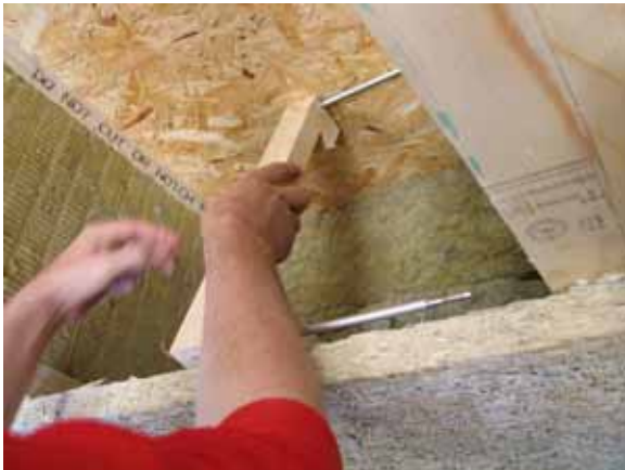
Abbildung 85 – Einbau der kombinierten Temperatur- und Feuchtesensoren
