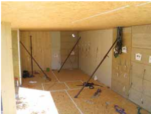
Abbildung 14 – Innenansicht nach Versetzen der Decke
