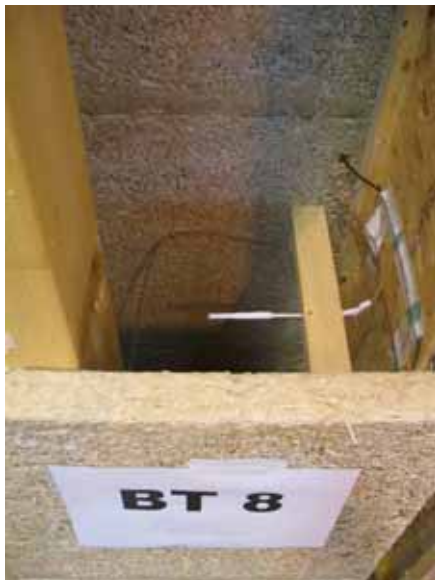
Abbildung 114 – Einbau der kombinierten Temperatur- und Feuchtesensoren
