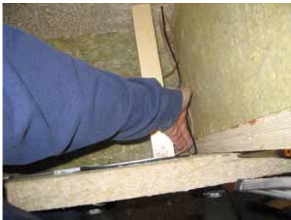
Abbildung 105 – Einbau der kombinierten Temperatur- und Feuchtesensoren
