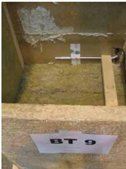
Abbildung 123 – Einbau der kombinierten Temperatur- und Feuchtesensoren
