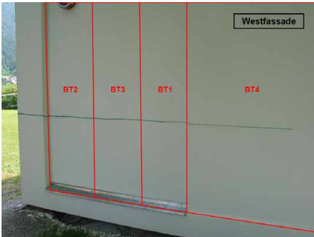
Abbildung 54 - Ansicht Westfassade mit Elementteilung der untersuchten Aufbauten
