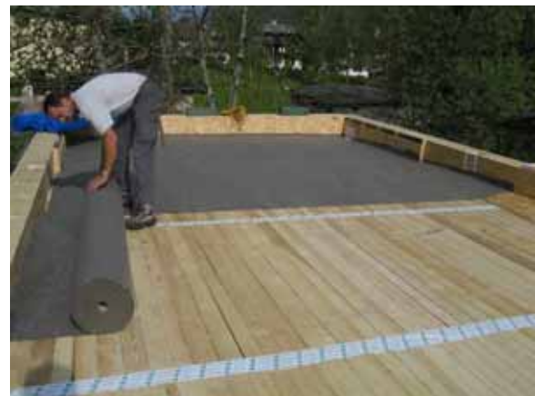
Abbildung 15 – Aufbringen der Ausgleichslage für die Flachdach- Abdichtungsbahn
