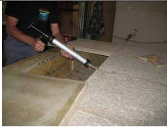
Abbildung 125 - Verkleben der beschichteten Heraklith EPV Platten
