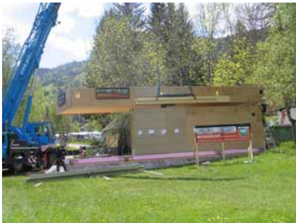
Abbildung 12 – Versetzen des Dachelementes
