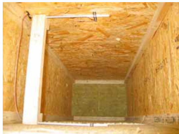
Abbildung 96 – Eingebaute Temperatur- und Feuchtesensoren
