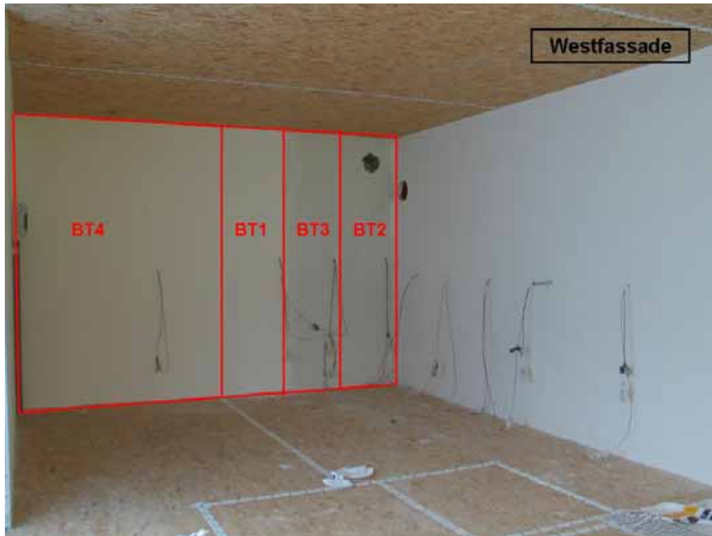
Abbildung 56 - Innenansicht der Westfassade mit untersuchten Wandaufbauten im Bauzustand
