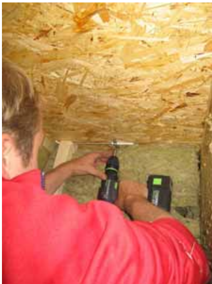
Abbildung 133 – Einbau der kombinierten Temperatur- und Feuchtesensoren
