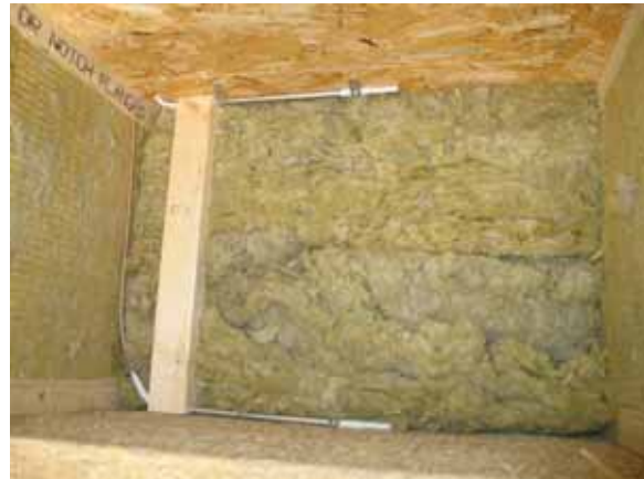
Abbildung 86 – Eingebaute Temperatur- und Feuchtesensoren
