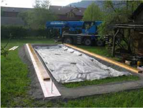
Abbildung 2 – Provisorisches Fundament des Testgebäudes
