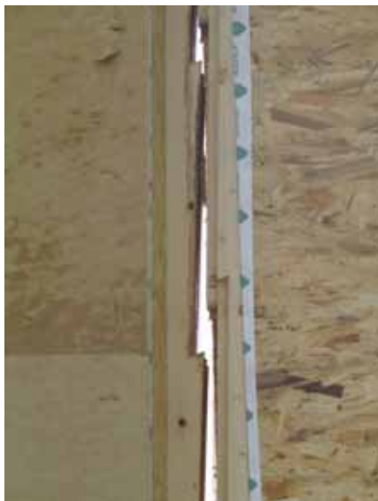
Abbildung 8 – Detailaufnahme der Verbindung zweier Wandelemente
