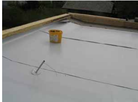
Abbildung 17 – Verlegen der Flachdach- Abdichtung
