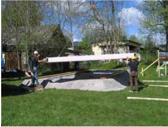
Abbildung 4 – Versetzen des Bodenelementes
