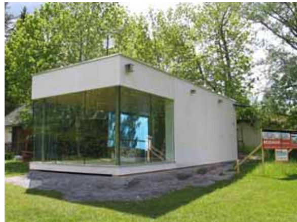
Abbildung 19 – Testgebäude nach Einbau der Fensterelemente
