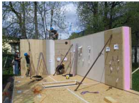
Abbildung 9 – Abstützen der versetzten Wandelemente
