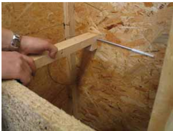
Abbildung 95 – Einbau der kombinierten Temperatur- und Feuchtesensoren
