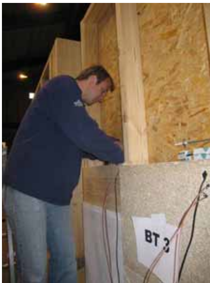
Abbildung 68 – Einbau der Messtechnik
