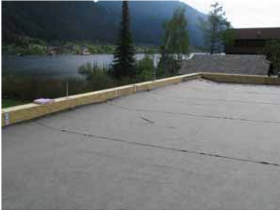
Abbildung 16 - Ausgleichslage für die Flachdach- Abdichtungsbahn
