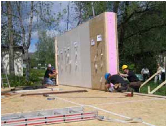
Abbildung 6 – Versetzen eines Wandbauteiles
