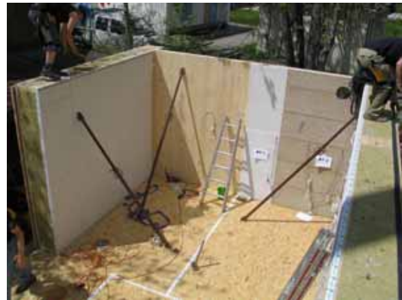
Abbildung 11 – Vorbereitungsarbeiten für das Versetzen des Dachelementes
