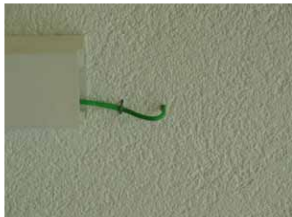
Abbildung 31 - Eingebauter Oberflächentempersensor
