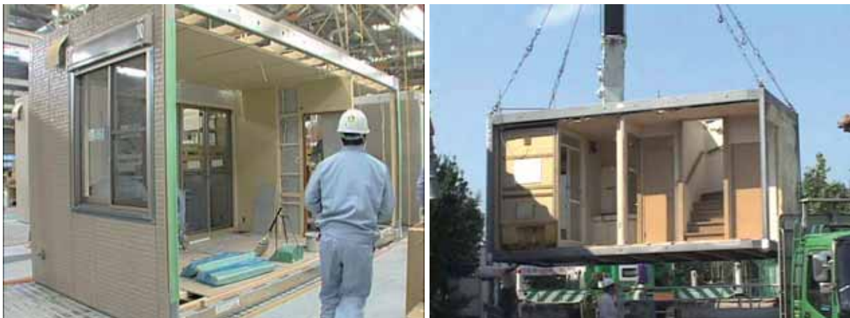
Abbildung 69: Module bei der Fertigstellung/Einbau.
