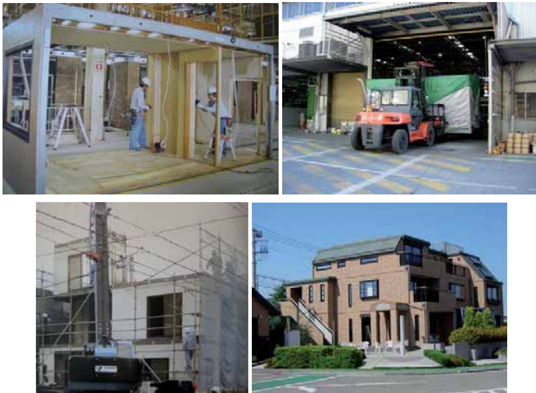
Abbildung 28: Fertigung, Transport und Aufbau des modularen Gebäudes.
