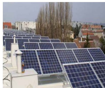
100 m 2 Kollektorfläche zur Warmwasserbereitung und Heizungsunterstützung sowie 93 m 2 Photovoltaikpaneele als integraler Bestandteil des Gebäudekonzeptes in der Wiener Schellenseegasse (Bildquelle: Büro Reinberg).
