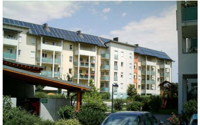
Der Sonnenhof in Krets-Weinzierl umfasst 79 Wohneinheiten – ein Inbegriff für Ökologie (208 m 2 thermische Solaranlage, 203 m 2 Photovoltaikanlage)
