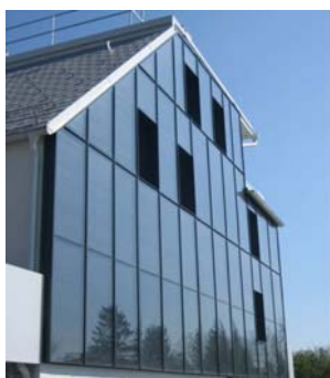
100 m 2 Kollektorfläche zur Warmwasserbereitung und Heizungsunterstützung sowie 93 m 2 Photovoltaikpaneele als integraler Bestandteil des Gebäudekonzeptes in der Wiener Schellenseegasse (Bildquelle: Büro Reinberg).
