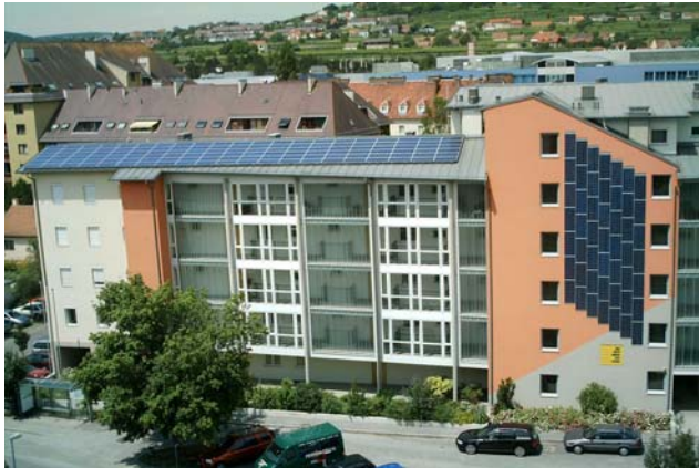
Der Sonnenhof in Krets-Weinzierl umfasst 79 Wohneinheiten – ein Inbegriff für Ökologie (208 m 2 thermische Solaranlage, 203 m 2 Photovoltaikanlage)
