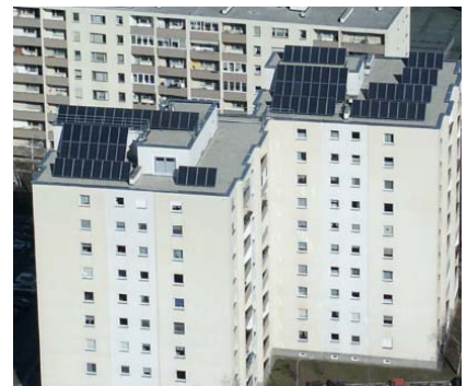
Sanierungsprojekt Krets, Mitteraustraße -ein Paradebeispiel für die Integration einer Solaranlage im Zuge einer umfassenden Gebäudesanierung
