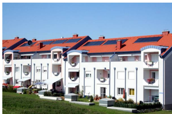
Aus vier Heizzentralen werden 182 Wohnungen in Mattersburg mit Solarwärme (450 m 2 Kollektorfläche) und Erdgas versorgt
