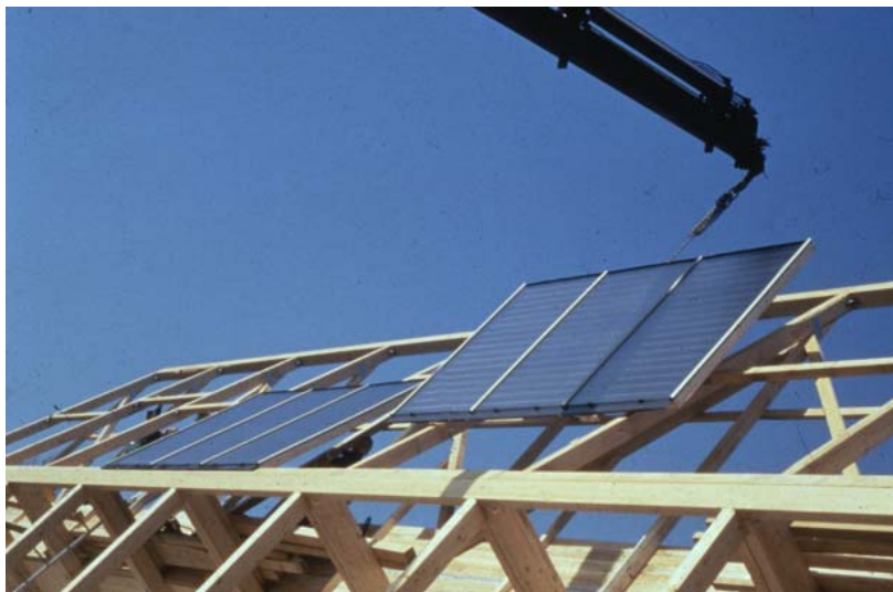
Abbildung 4: Standard bei Solaranlagen im Geschosswohnbau - Kranmontage von Großflächenkollektoren
