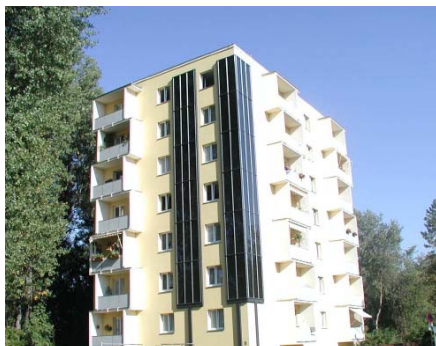
Sanierungsprojekt Krets, Admonterstraße -ein Musterbeispiel für Solar-kollektoren als Gestaltungselement
