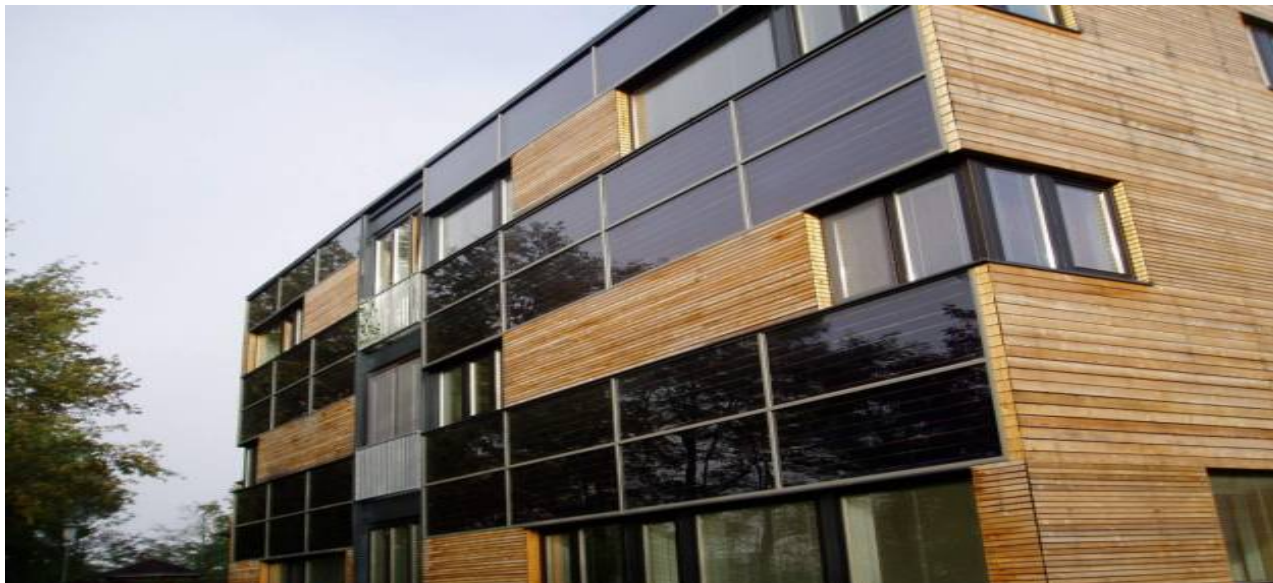
Formschöne Fassadenintegration von solarthermischen Kollektoren bei der Wohnanlage Aussichtsstraße in Villach.
