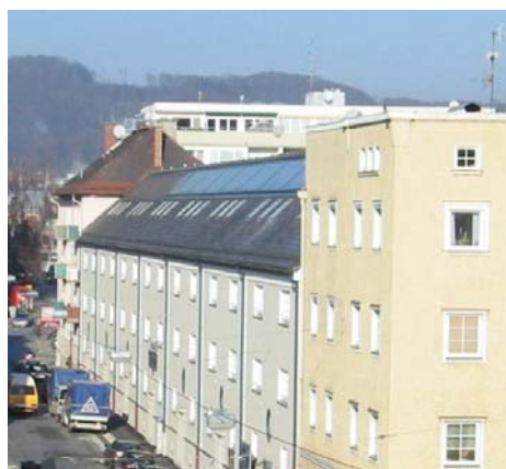
Abbildung 7: Im Zuge einer umfassenden Modernisierung wurde in der Salzburger Plainstraße (42 Wohneinheiten) vom Wohnbauträger gswb eine Solaranlage mit 164 m 2 Kollektorfläche in Verbindung mit einem Wärmeversorgungskonzept nach dem Prinzip von „Zwei-Leiter-Netzen“ und Wohnungsstationen umgesetzt (Bildquelle: gswb)
