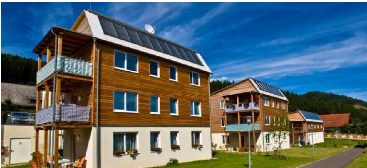
Solarwärmenutzung als Standard in den Wärmeversorgungskonzepten der Siedlungsgenossenschaft Ennstal, wie hier dargestellt in der Wohnanlage St. Peter Freienstein (21 Wohneinheiten, 72 m 2 Kollektorfläche)
