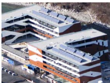
Solarwärme als Standard in den Wärmeversorgungskonzepten des Bauträgers Neue Heimat Tirol (Links: Wohnanlage Hüttenmühlsee, Reutte; Mitte: Wohnanlage Bruckfeldstraße, Landeck; Rechts: Bildausschnitt Tivoli Areal)
