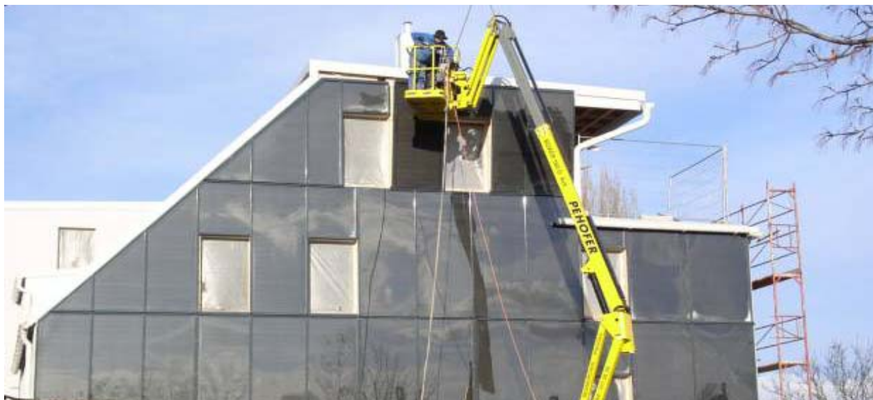
Formschön realisierte Solarwärmenutzung bei der Passivhauswohnanlage Schellenseegasse in Wien (Bildquelle: Büro Reinberg)
