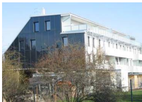
100 m 2 Kollektorfläche zur Warmwasserbereitung und Heizungsunterstützung sowie 93 m 2 Photovoltaikpaneele als integraler Bestandteil des Gebäudekonzeptes in der Wiener Schellenseegasse (Bildquelle: Büro Reinberg).
