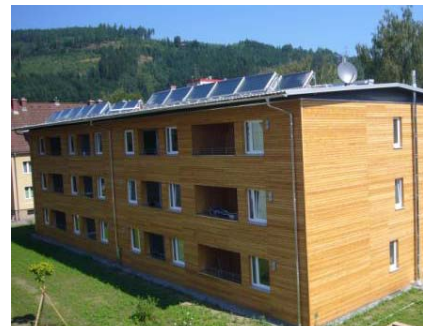
Niedrigenergie- oder Passivhausstandard in Verbindung mit erneuerbaren Energieträgern, insbesondere Solarwärme (Links: Wohnanlage mit 83 WE in der Parkstraße/Leonding; Mitte: 12 WE in Spital/Pyhrn; Rechts: Solarwärmenutzung an einer Wohnanlage in Leopoldsdorf)
