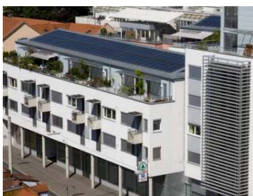
260 m 2 am 63 Wohnungen und Geschäftslokale umfassenden Projekt in der Lange Gasse, Graz
