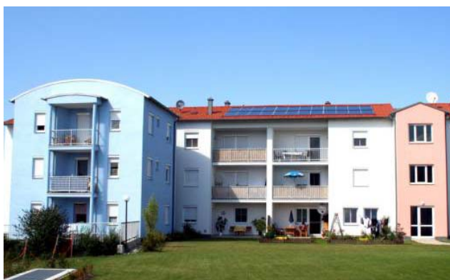
72 m 2 Kollektorfläche am 21 Wohnungen umfassenden Wohnprojekt in der Arbeitergasse, Schattendorf.
