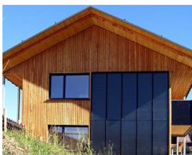
Solarkollektoren zur Warmwasserbereitung und Heizungsunterstützung in Niedrigenergie- und Passivhausprojekten der Vorarlberger VOGEWOSI.
