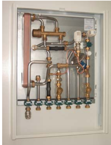
Abbildung 5: Wohnungsstationen in Verbindung mit Zwei-Leiter-Netzen als Basis effizienter solarunterstützter Wärmeversorgungsansätze
