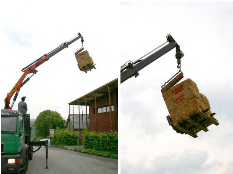
Abbildung 35: Beförderung mit einem Kran
