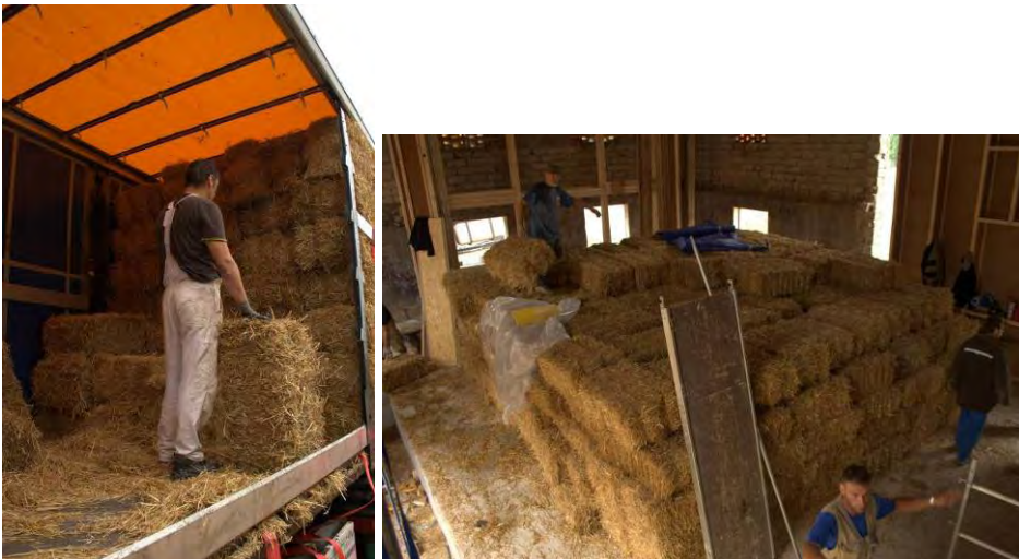
Abbildung 33: Lieferung und Lagerung auf der Baustelle
