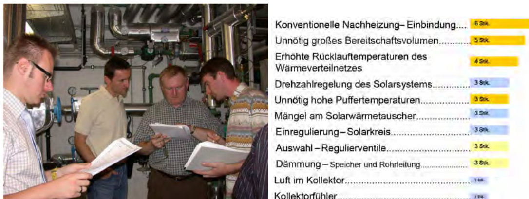
Abbildung 12: Quantifizierung der häufigsten Optimierungsmaßnahmen.
