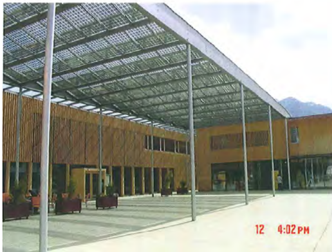
Abbildung 19: Semitransparentes Dach des Gemeindezentrums Ludesch/Vbg. mit gerahmten Glas-Glas-Modulen.
