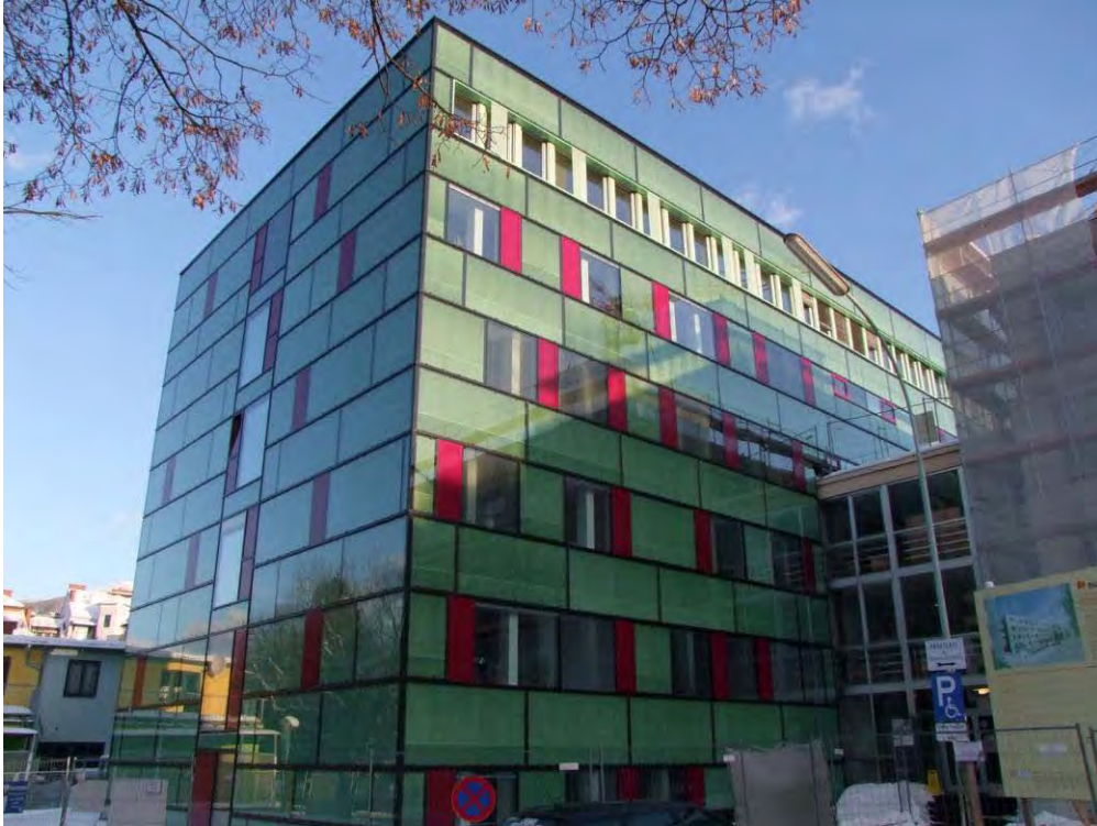
Abbildung 47: Bauteil Finanzamt und BEV, fertige Fassade mit Solarwaben (Bildquelle: Grazer Energieagentur GmbH)
