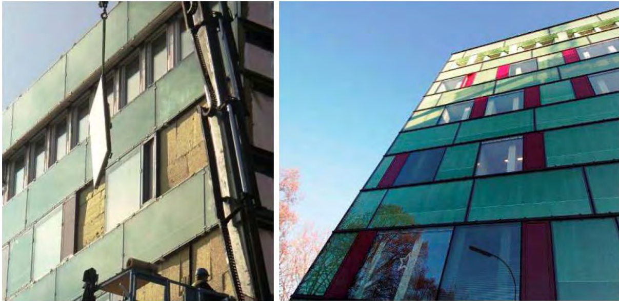
Abbildung 49: Links: Montage der Paneele (Quelle: gap-solution); Rechts die fertige Fassade
