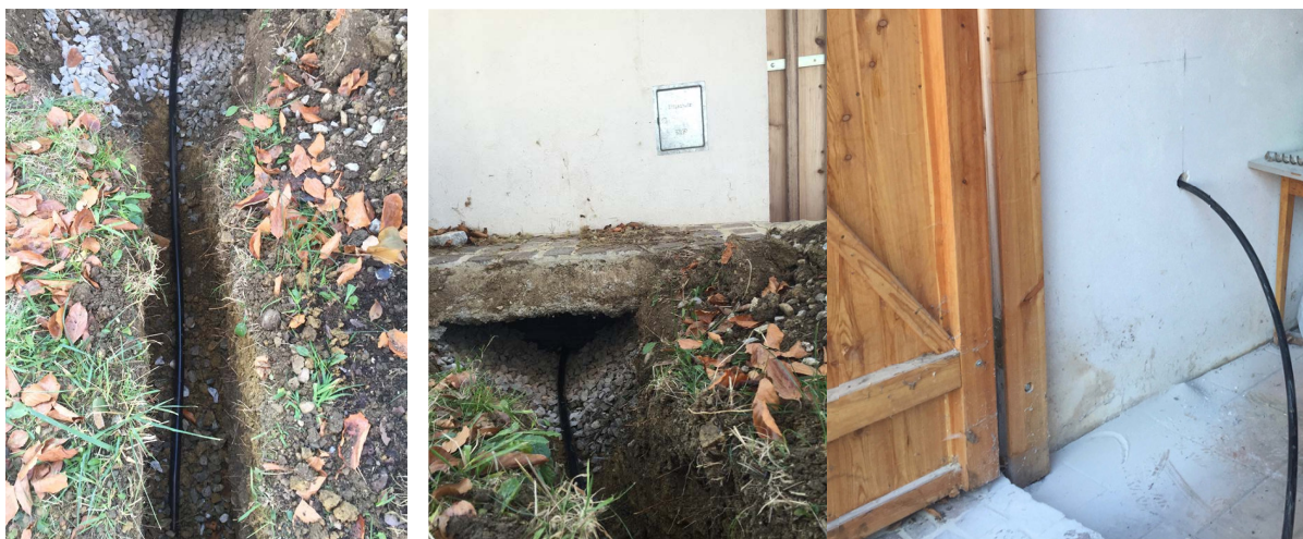
Abbildung 12: Verlegung der Direktleitung Pilotprojekt 2
