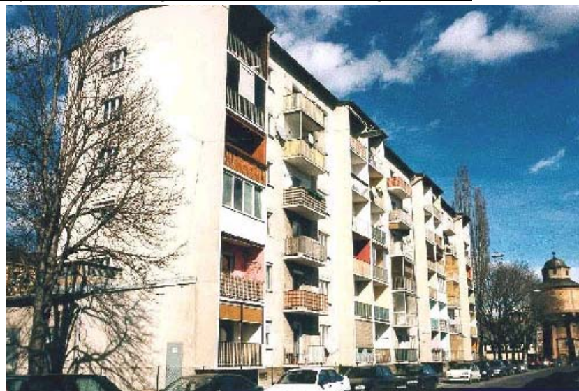
Abbildung 41: Typisches Wohngebäude aus den siebziger Jahren
