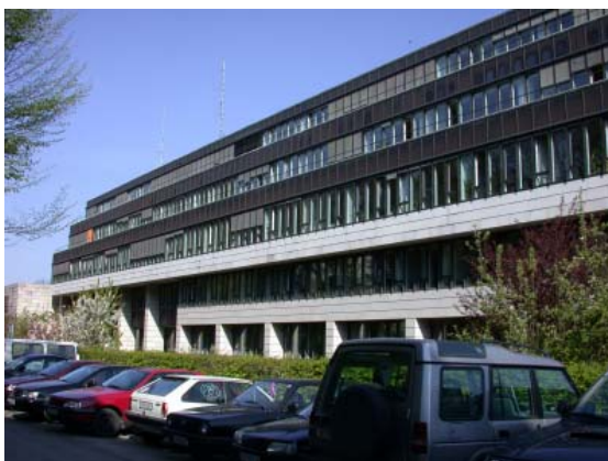
Abbildung 79: Südansicht des Landhaus Bregenz. Vor allem Büroräume im 6. und 7. Obergeschoß weisen auf dieser Seite Raumtemperaturen von deutlich über 30°C auf.
