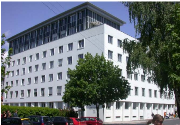
Abbildung 160: Südwest-Ansicht des Oberlandesgerichts Linz. In den obersten zwei Geschossen treten in den Sommermonaten Raumtemperaturen über 26°C auf
