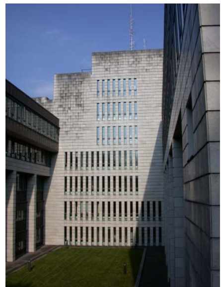
Abbildung 92: Ansicht der westseitigen Granitplatten-Fassade.
