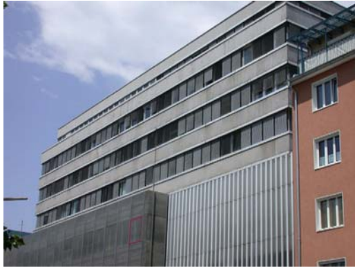
Abbildung 30: Südansicht des Objektes
