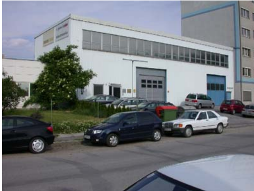
Abbildung 28: Ostsicht des Objektes
