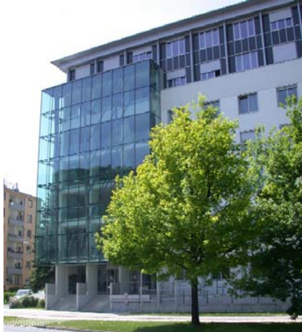
Abbildung 12: Ostansicht des Objektes
