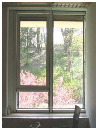
Abbildung 93: Innenansicht eines Standardfensters im Landhaus Bregenz
