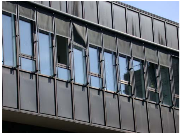
Abbildung 116: Häufig defekte Screens führen zu hohen Instandhaltungskosten
