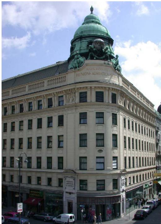
Abbildung 15: Südwest Ansicht des Gebäudes.
