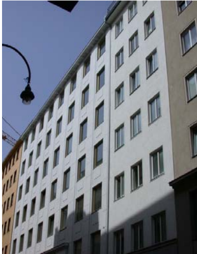
Abbildung 21: Südansicht des Objektes
