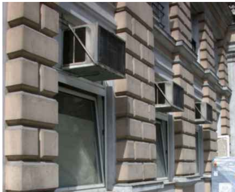
Abbildung 76: Nachrüstung von dezentralen Klimageräten auf Grund von überhöhten Raumtemperaturen – eine ästhetisch und energetisch unbefriedigende Lösung
