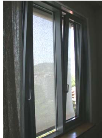
Abbildung 168: Innenansicht des derzeitigen Verschattungssystems bei einem Standardfenster im 6. OG
