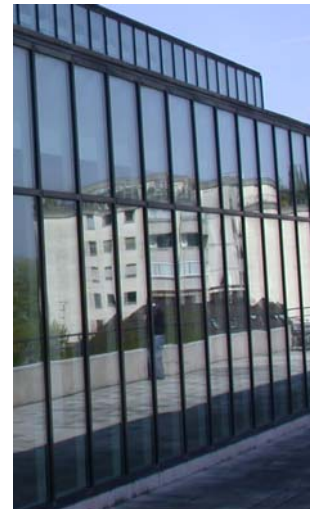
Abbildung 101: Nordfassade, hier der Restaurantbereich, ohne Verschattungseinrichtung
