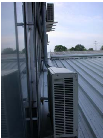
Abbildung 29: Westfassade mit Rückkühlern
