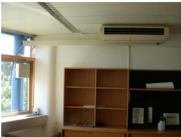
Abbildung 25: Nachträglich installierte Splitgeräte in den süd-orientierten Büros
