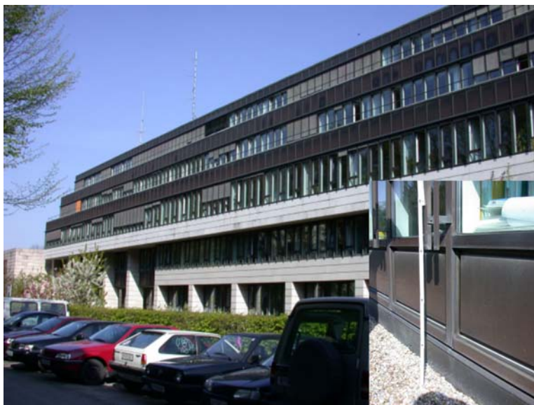
Abbildung 91: Ansicht der Südfassade. Im kleinen Bild ist ein Detailausschnitt der Kupferfassade dargestellt.
