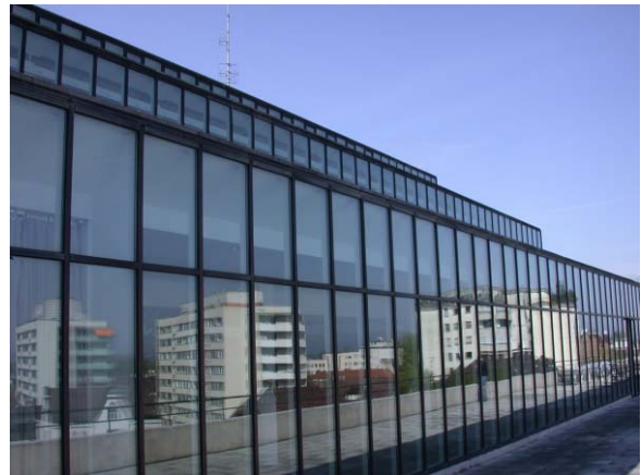
Abbildung 96: Nordseitige Ansicht der Verglasung im Kantinenbereich
