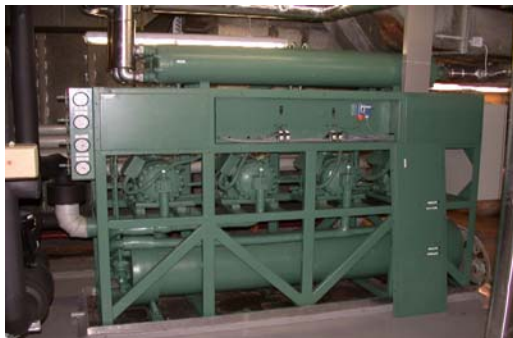
Abbildung 31: Kompressionskältemaschine mit Grundwassernutzung
