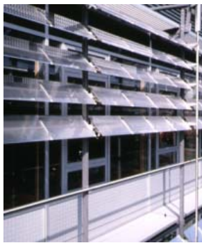
Abbildung 119: Prismenelemente als Tageslichtlenksystem (Siteco, 2002)
