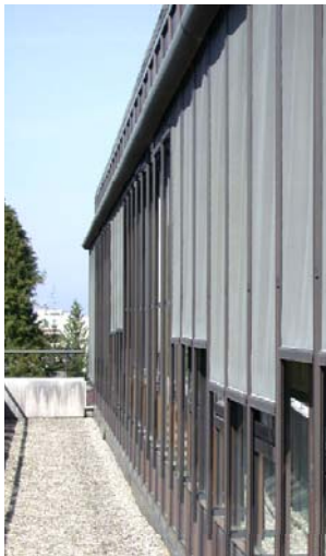
Abbildung 100: Südfassade mit dem derzeitigen Verschattungssystem (braune Stoffscreens) im 7. OG des Landhaus Bregenz
