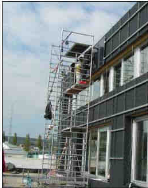
Abb.: Modulmontage mittels Gerüst; Montage von der Mitte aus
