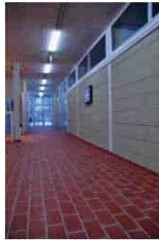
Klinkerboden und Sicht-Lehmwände im Erdgeschoss
