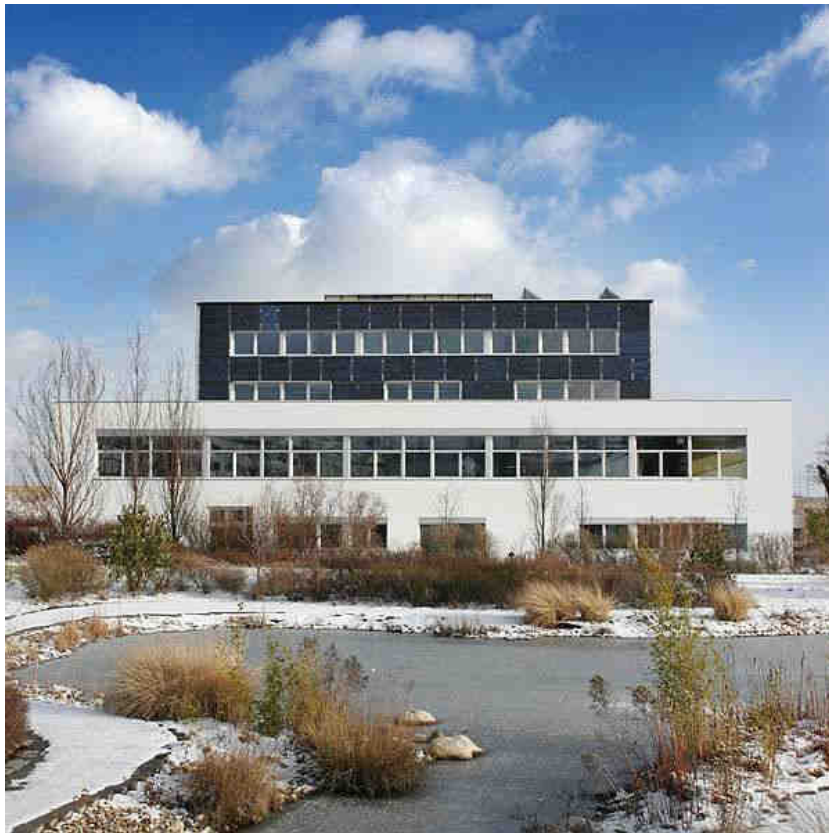
Bild: Ostfassade, Januar 2005, © Thomas Kirschner
