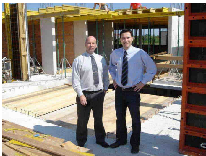
Photo: Mag. Robert Novak (Wopfinger Baustoffindustrie), Tony Cooper (Golden Bay Cement, Neuseeland) Baustelle SOL 4 Passiv-Büro-Haus Mödling
