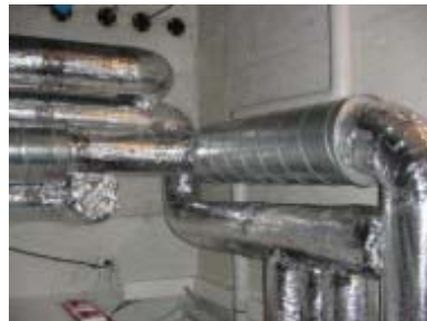
Abbildung 3.142: Vorbildlich gedämmte Lüftungsrohre
