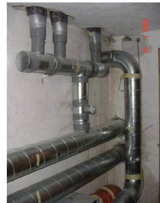
Abbildung 8.12: Luftmengenregelung und Zuluftverteiler für Bodenkanäle im Wohnzimmer und Essbereich (3 Auslässe a 25m 3 /h) und Fortluftführung. Provisorische Klebebänder.
