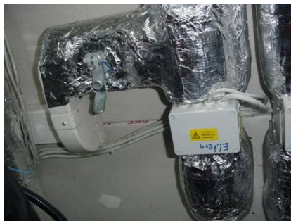
Abbildung 3.34: Stromnachheizung und Einbindung kalter Zuluft für das Elternschlafzimmer
