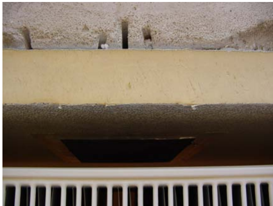
Abbildung 8.20: Luftauslass (unsichtbar) hinter dem Heizkörper (Bild ohne Fensterbrett) 4cm dicke Dämmung hinter dem Heizkörper (Außendämmung 16 cm)
