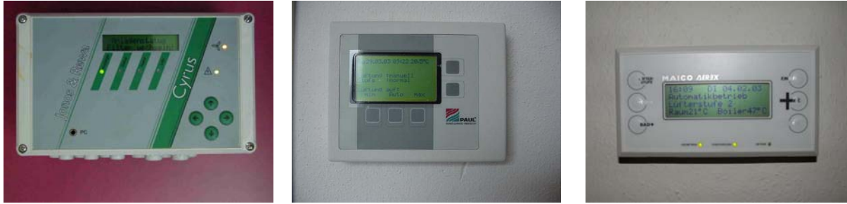
Abbildung 3.92 a-c: Bediengeräte für Wohnraumlüftungen mit Nachheizung bzw. mit Wärmepumpe
