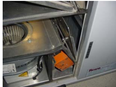
Abbildung 8.10 a-c: Automatische Bypassklappe: geschlossen – halboffen - offen
