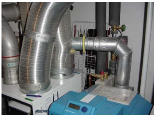
Abbildung 3.38: Unzulässige Einbindung der Rauchgase in die Abluft
