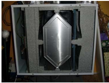
Abbildung 2.22: Lüftungsgerät mit Kreuz-Gegenstrom-Wärmetauscher
