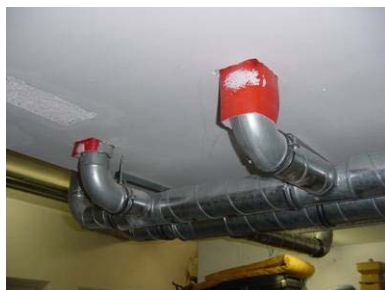
Abbildung 3.139: Schalltechnische Entkopplung durch Rohrschlauch
