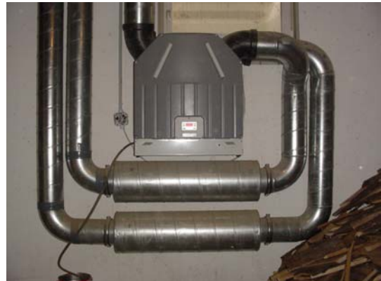
Abbildung 1.1: Lüftungsgerät mit PE-Verrohrung (Kondensatablauf fehlt)
