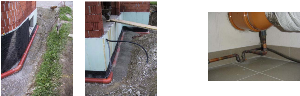
Abbildung 3.72 a-c: Erdwärmetauscherdetails
