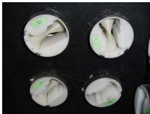
Abbildung 2.34: Konstantvolumenstromregler (15 bzw. 25 m³/h) in einer Verteilerbox
