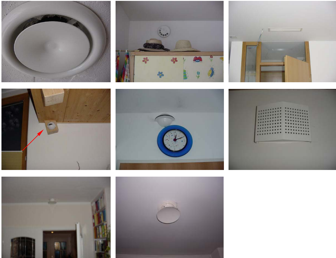
Abbildung 3.132 a- h: Beispiel für Zuluftventile (Induktionslüftung)
