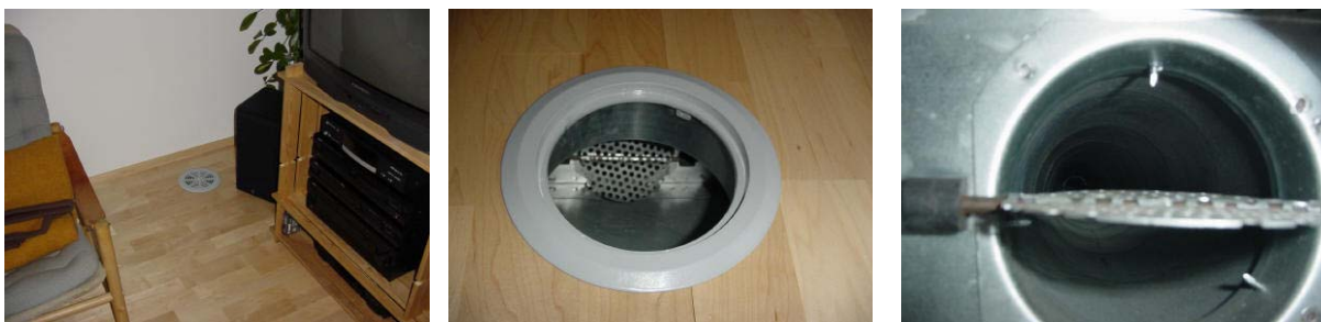
Abbildung 3.135 a-c: Bodenauslass mit Luftmengenregulierung
