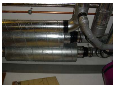
Abbildung 3.47: Starrer Schalldämpfer
