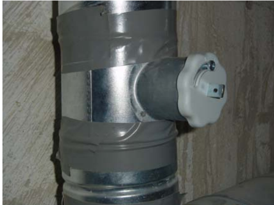
Abbildung 8.13: Drosselklappe für Luftmengenregulierung (Quellluftauslass ohne Regelmöglichkeit)
