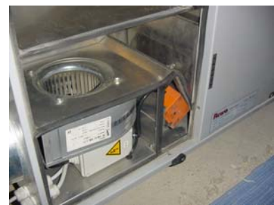
Abbildung 8.10 a-c: Automatische Bypassklappe: geschlossen – halboffen - offen
