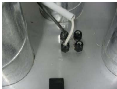
Abbildung 3.84: Undichte, nicht verwendete Kabeldurchführungen
