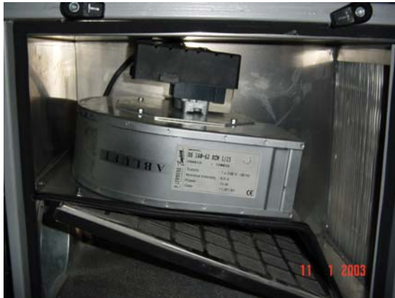
Abbildung 8.8: Abluftventilator (Gleichstrom) und Abluftfilter (dieser kann theoretisch verkehrt montiert werden)
