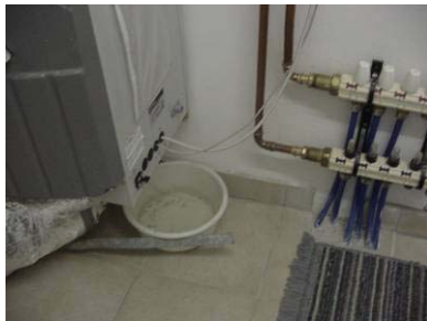
Abbildung 3.111: Provisorische Kondensatsammlung mit Behälter
