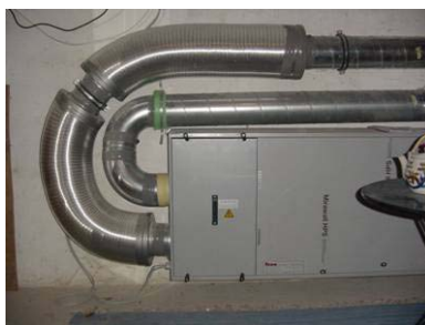
Abbildung 3.46 a-b: Flexible Schalldämpfer
