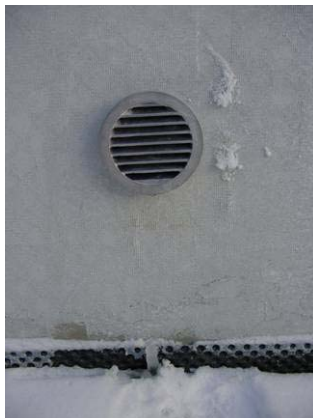
Abbildung 8.16: Gefrorenes Kondensat an der Außenwand bei der Abluft (Außentemperaturen von -8 bis -15°C und leichtem Wind). Neg: Einfaches Abluftgitter mit normalem Rohrquerschnitt (Durchmesser 160 mm). Dadurch relativ hoher Druckverlust.
