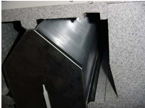
Abbildung 3.83: Lüftungsgerät mit Kunststoff-Wärmetauscher
