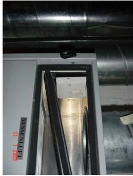
Abbildung 3.106: Thermostat im Frischluftbereich für Sommerbypass
