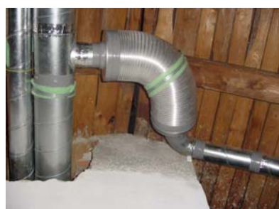
Abbildung 3.137: Telefonieschalldämpfer im Abluftbereich
