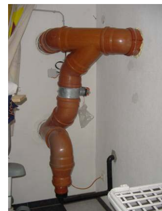
Abbildung 3.67 a-b: Umschaltklappen zwischen Direktansaugung und über EWT (Ausführung in KG-Rohr)
