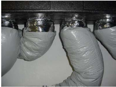
Abbildung 3.45 a-c: Schlauch-Schalldämpfer
