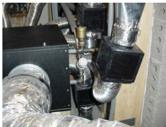
Abbildung 3.30: Nachheizregister in der Verteilerbox bei einer Anlage ohne EWT
