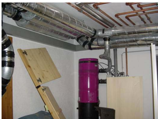
Abbildung 3.39: Problematische Einbindung des Zentralstaubsaugers in die Fortluft
