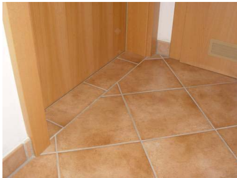
Abbildung 3.127: Schleiftür mit zu geringem Abstand (Kinderzimmer) und Tür mit Überströmigitter (Abstellraum)
