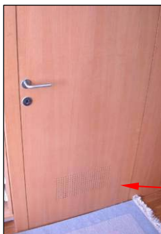
Abbildung 3.128: Eine der wenigen Anlagen mit gelochtem Türblatt
