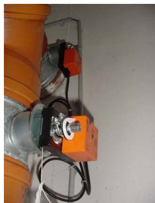
Abbildung 3.67 a-b: Umschaltklappen zwischen Direktansaugung und über EWT (Ausführung in KG-Rohr)
