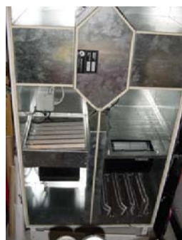
Abbildung 3.82: Lüftungsgerät mit Wechselstrommotoren
