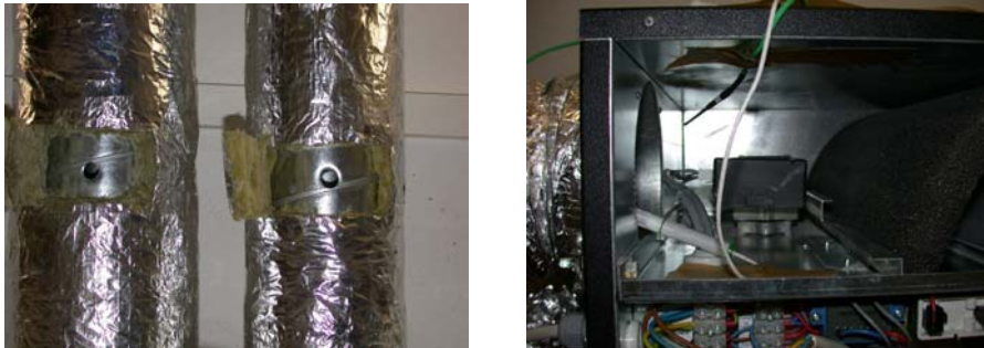
Abbildung 3.3 a-b: mögliche Fühlerpositionen (Combi-Fühler & Thermoelement abluftseitig in Gerät positioniert)
