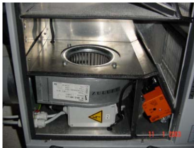
Abbildung 8.10 a-c: Automatische Bypassklappe: geschlossen – halboffen - offen
