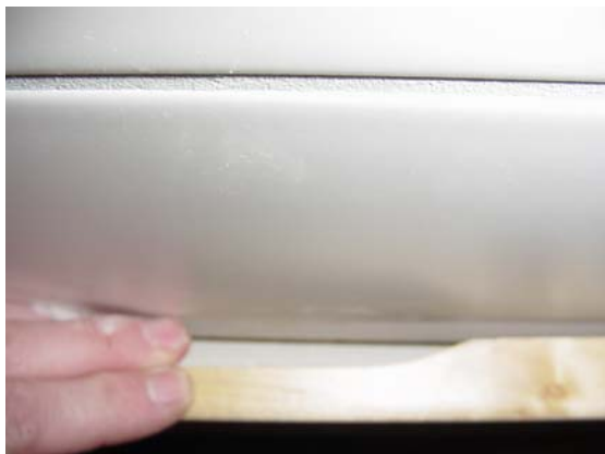
Abbildung 8.22: Verdeckte Luftführung über die Türzarge (1 cm Spalt)
