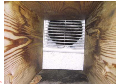
Abbildung 3.63 a-b: Diese im Holzstapel versteckte, Frischluftansaugung bedeutet zusätzliche Druckverluste und erschwert ein Reinigen des Ansauggiters.
