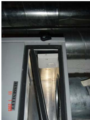
Abbildung 8.11: Thermostat für Umschaltung des Sommerbypasses auf der Frischluftseite (Nach dem EWT)
