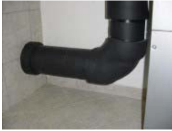
Abbildung 3.141: Feuchtebeständig gedämmte Frischluftansaugung
