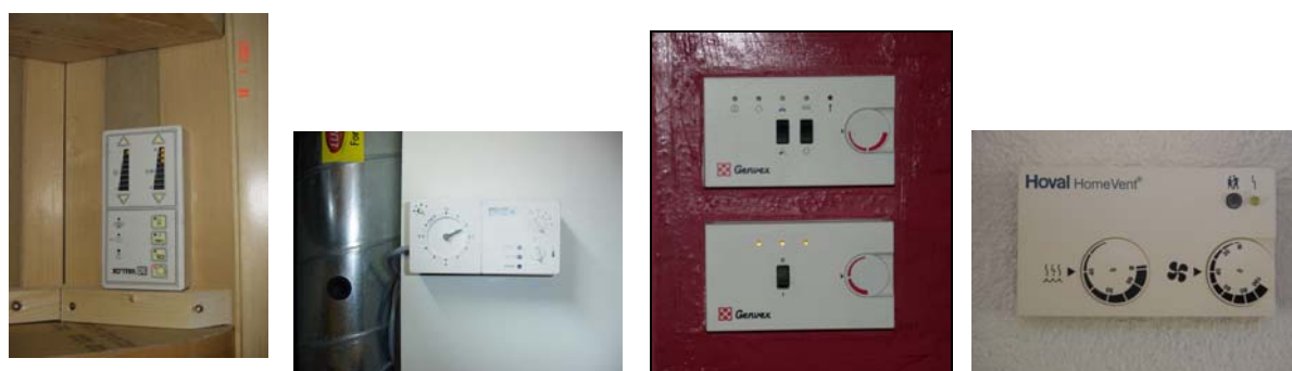
Abbildung 3.91 a-c: Umfassende Bediengeräte für Wohnraumlüftungen mit Filterwechselanzeige bzw. Zeitschaltuhr.
