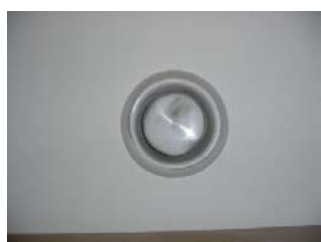
Abbildung 3.131 a-b: Deutlich verschmutzte Abluftventile
