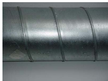
Abbildung 3.140: Kondensattropfen am Frischluftrohr
