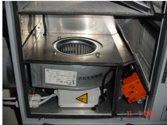
Abbildung 8.8: Abluftventilator (Gleichstrom) und Abluftfilter (dieser kann theoretisch verkehrt montiert werden)
