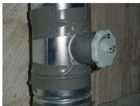
Abbildung 3.144: Drosselklappe zur Strangregulierung
