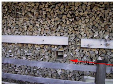
Abbildung 3.63 a-b: Diese im Holzstapel versteckte, Frischluftansaugung bedeutet zusätzliche Druckverluste und erschwert ein Reinigen des Ansauggiters.
