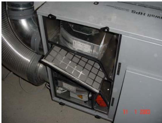
Abbildung 8.5: Filter auf der Abluftseite (kann theoretisch verkehrt eingebaut werden)
