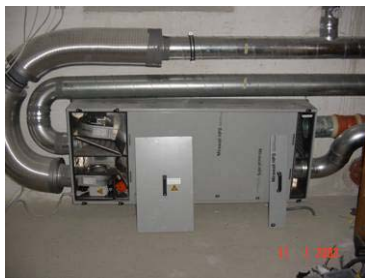
Abbildung 2.23: Lüftungsgerät mit Gegenstrom Wärmetauscher (Fa. Rewa)
