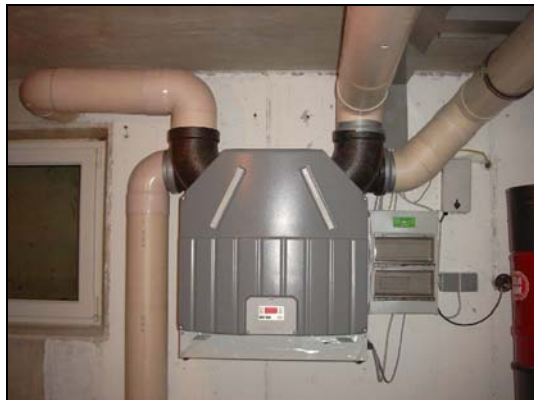
Abbildung 1.1: Lüftungsgerät mit PE-Verrohrung (Kondensatablauf fehlt)
