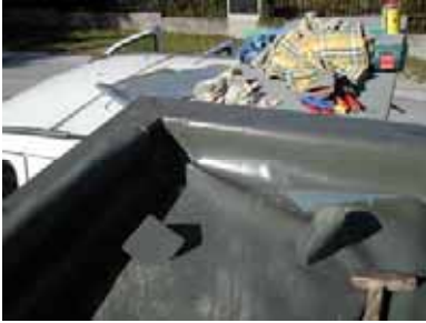
Abb. 170 Verschweißung einer wurzelfesten Abdichtung aus PVC auf einem Carport
