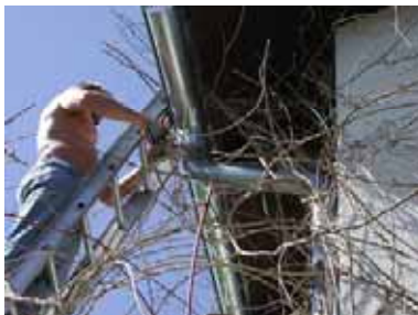
Abb. 161 Freischneiden einer Dachrinne um Schäden durch eine Wisteria zu vermeiden
