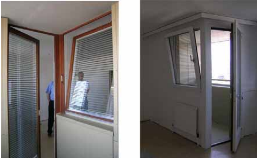
Abb. 226 Verglasung der Loggia, im Bild rechts ist die dünne Wand der Loggia gut erkennbar.
