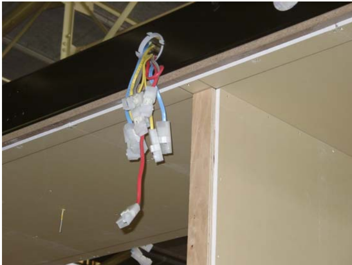
Abbildung 6: Werk Kasugai: Kabelbaumtechnologie aus der Automotivindustrie für Wohnbauten
