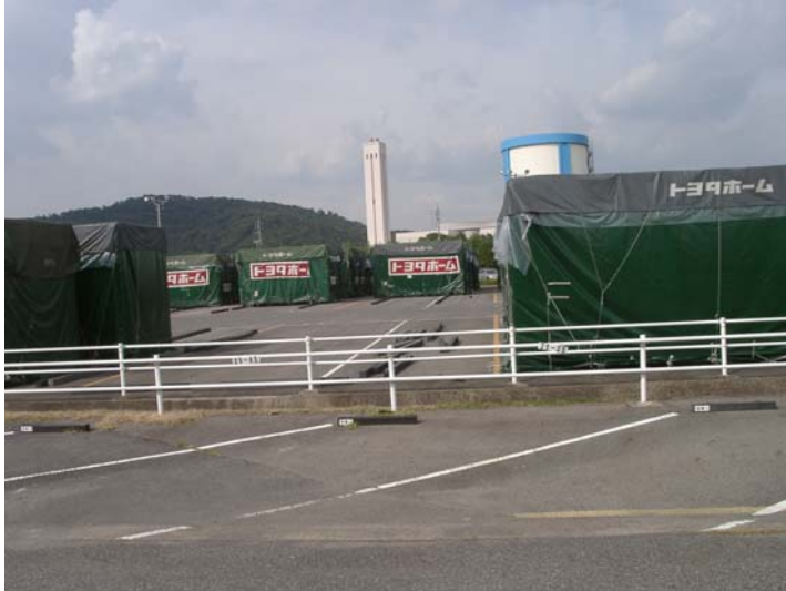
Abbildung 8: Werk Kasugai; Lager- und Verladeplatz des Werkes mit fertiggestellten Räumen für den Transport zum Bauplatz
