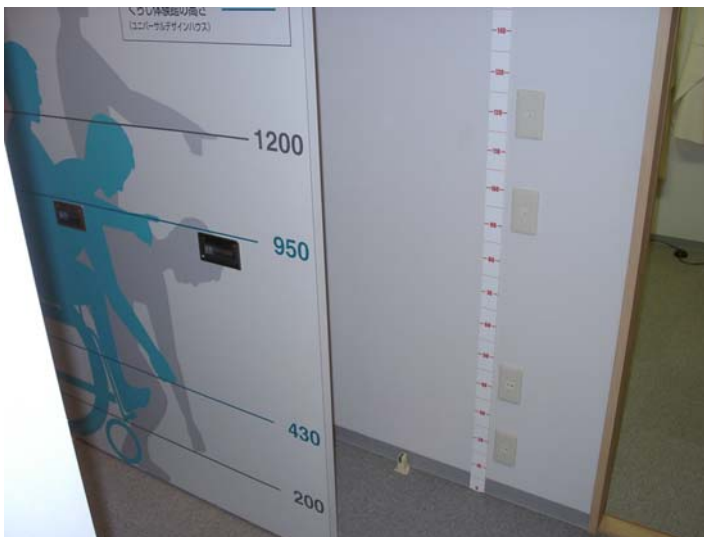
Abbildung 12: Atolis Park: Konfiguration der Elektroinstallationen hinsichtlich behindertengerechter Ausführung
