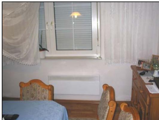
Abbildung 6.13: Neue Fenster mit Kunststoffrahmen, darunter ein Stromkonvektor
