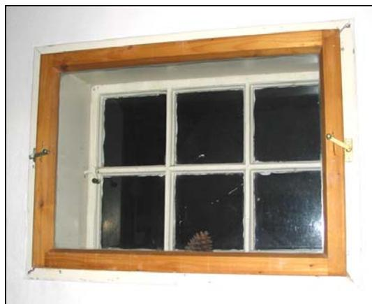
Abbildung 6.4: Einscheibiges Gangfenster mit vorgesetzter Zusatzscheibe
