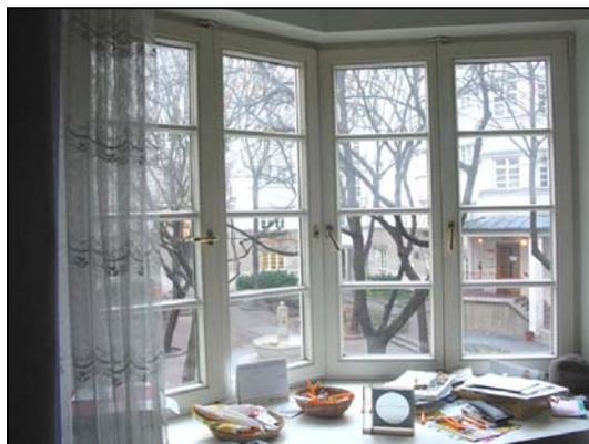
Abbildung 6.41: Beispiel für ein typisches neues Fenster im Erkerbereich.
