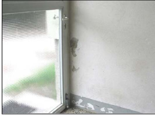
Abbildung 6.46: geringfügige Frostschäden wegen Kondensatbildung durch die Kältebrücke Stahl-Glas-Eingangstüre
