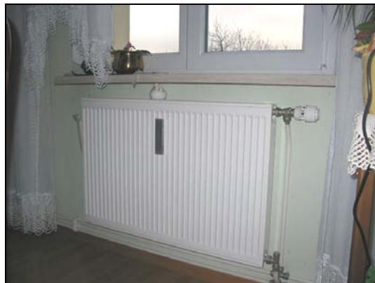
Abbildung 6.32: Neue Heizkörper mit Thermostatventil und Verdunstungsröhrchen; darüber die neuen Kunststofffenster;
