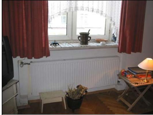
Abbildung 6.21: in Eigeninitiative getauschte Heizkörper mit Thermostatventilen und der etwa 20 Jahre alte Bestand an Kunststofffenstern.
