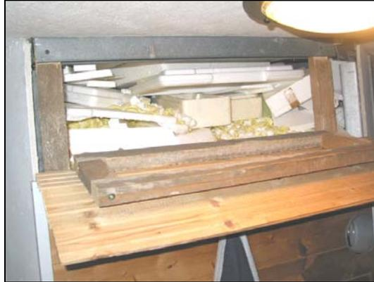
Abbildung 6.6: Isolierung des Pufferspeichers
