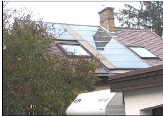
Abbildung 6.3: Selbstbaukollektor, welcher im Zuge der Sanierung errichtet wurde
