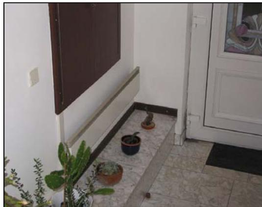
Abbildung 6.14: Stromkonvektor im Eingangsbereich des sanierten Gebäudes
