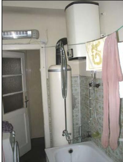
Abbildung 6.36: Badezimmer mit Festbrennstoff-Wasserkessel und Elektroboiler.
