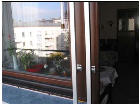
Abbildung 6.50: Die bei der Sanierung neu eingebauten 3-scheibig verglasten Holzrahmenfenster.
